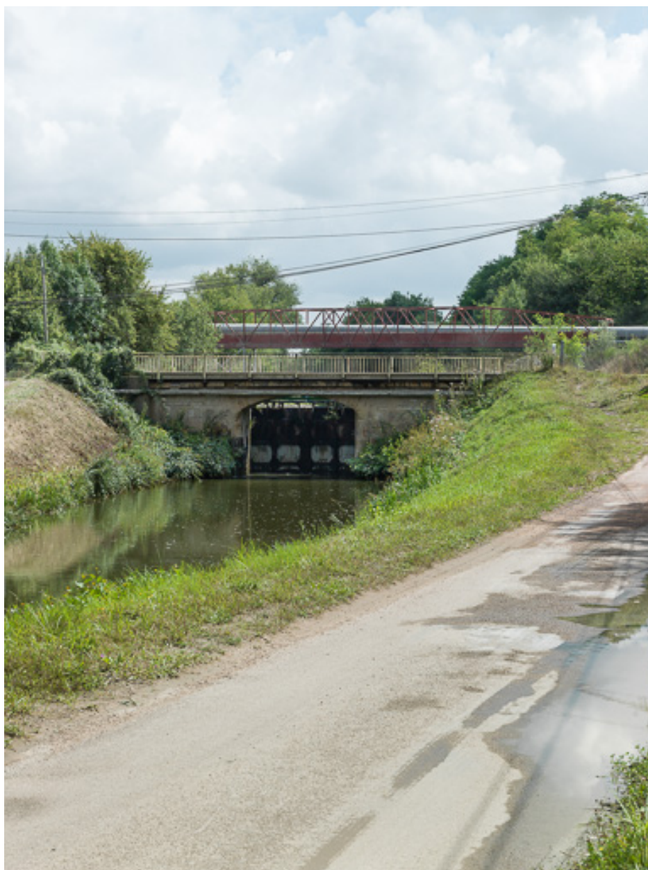
Vue d'ensemble du pont.
