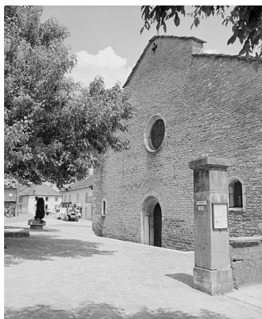
Façade ouest de l'église. Phot. Yves Sancey IVR43_19963900647X
