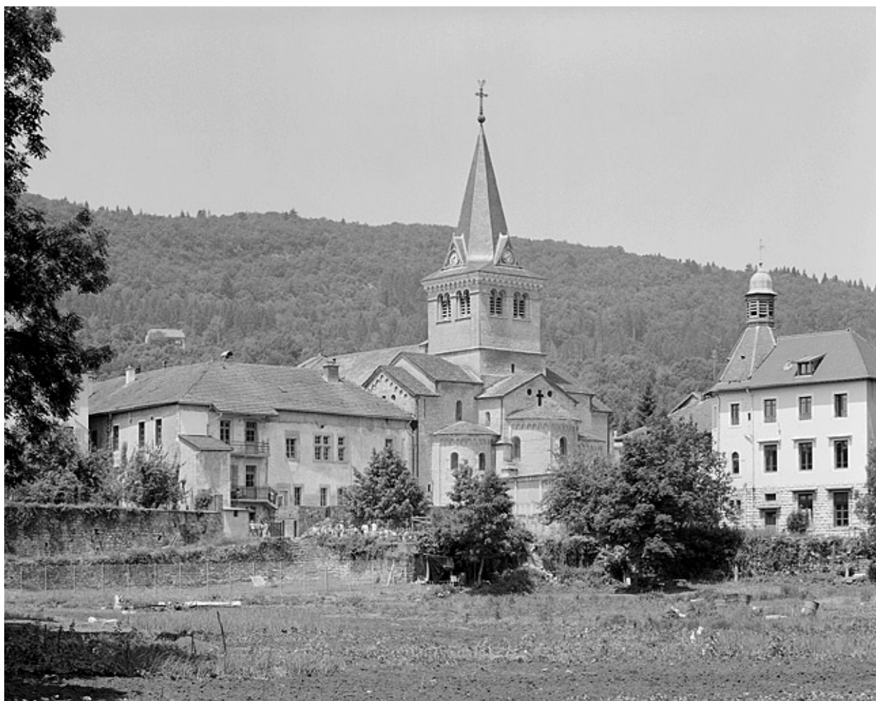
Vue générale depuis le sud-est.
