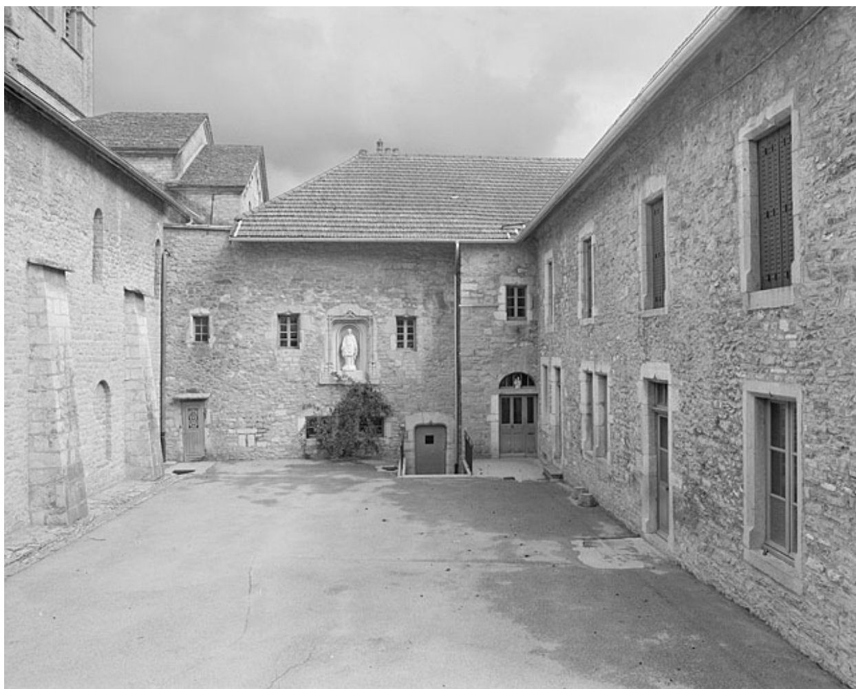
Façade ouest du prieuré.
