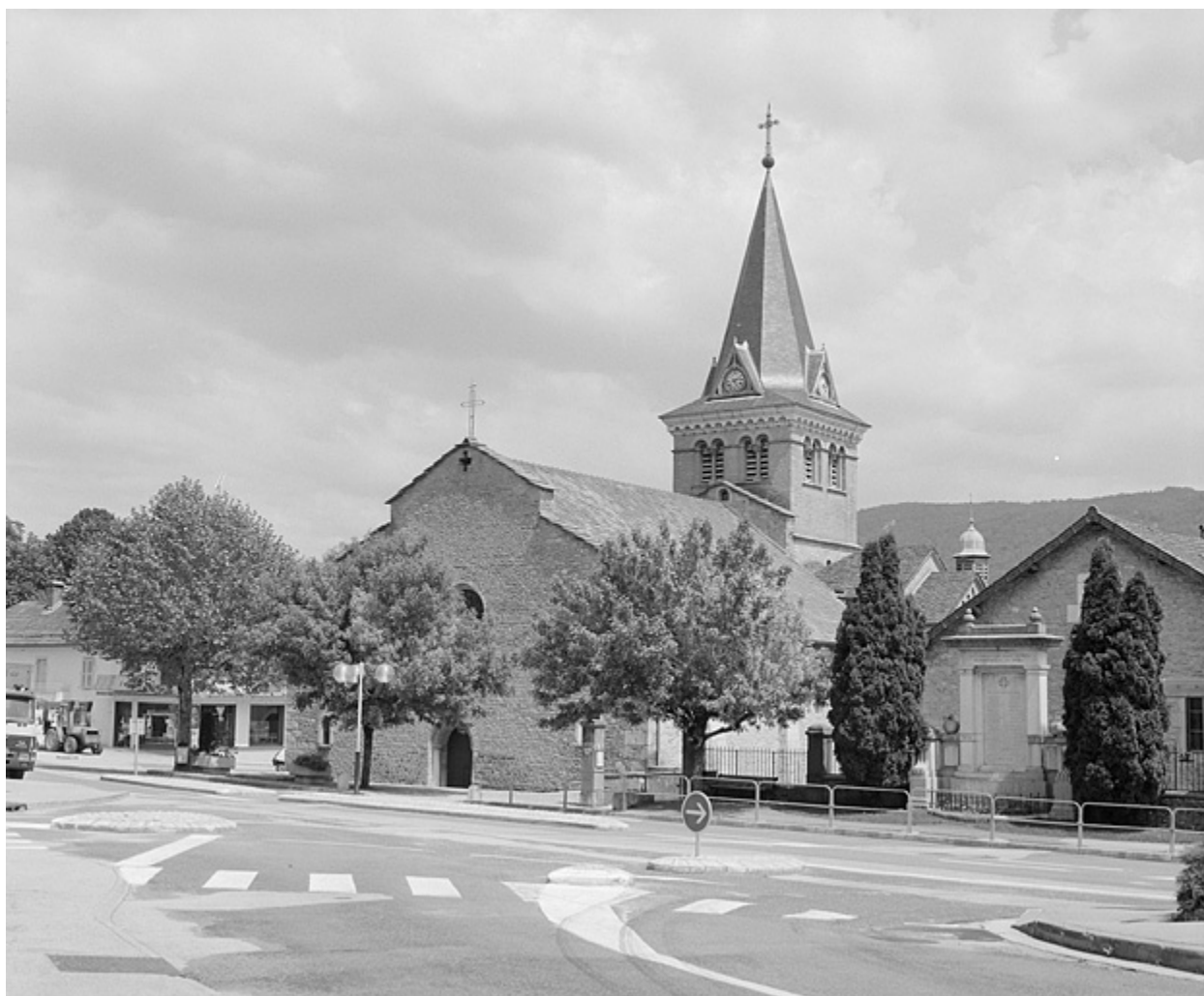
Vue de l'église depuis le sud-ouest.
