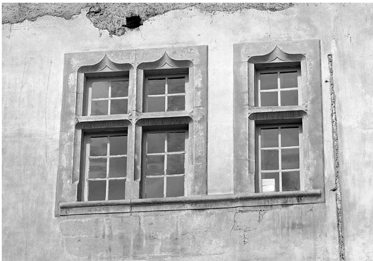
Fenêtres de l'étage de la face est.
