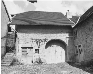
Ferme à Saint-Lothain. Phot. Dominique Dominguez IVR43_19783900147X
