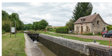
Le site d'écluse. Phot. Pierre-Marie Barbe-Richaud IVR26_20175800381NUC2AQ
