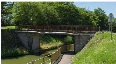
Le pont vu d'amont. Phot. Pierre-Marie Barbe-Richaud IVR26_20137100539NUC4AQ
