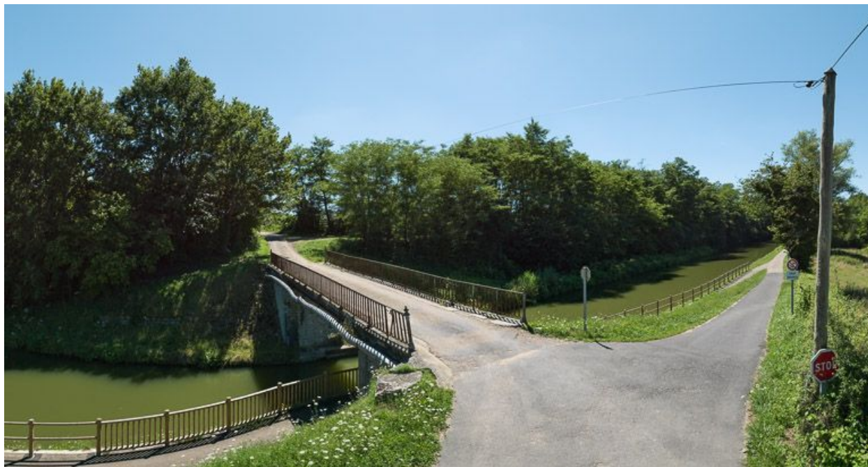
Le pont vu du dessus.
