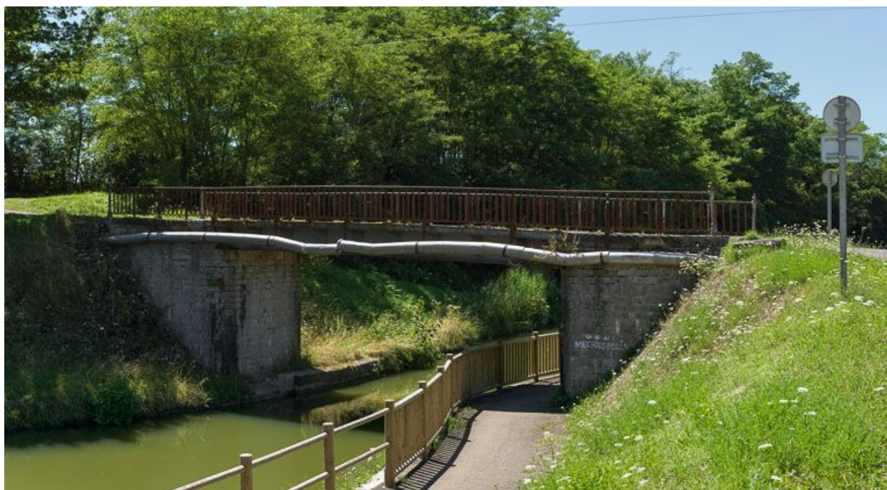
Le pont vu d'amont.
