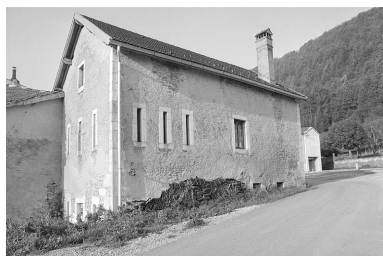
Face gauche et façade postérieure. Phot. Jérôme Mongreville IVR43_19963901605X
