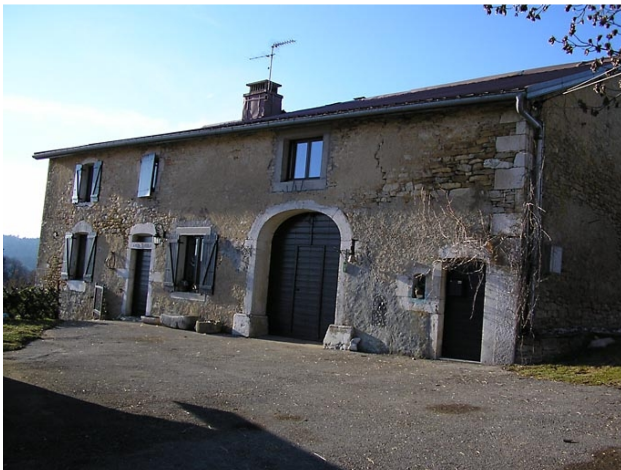
Façade antérieure vue de trois quarts.
