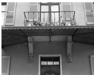
Détail du balcon. Phot. Yves Sancey IVR43_19917000399X
