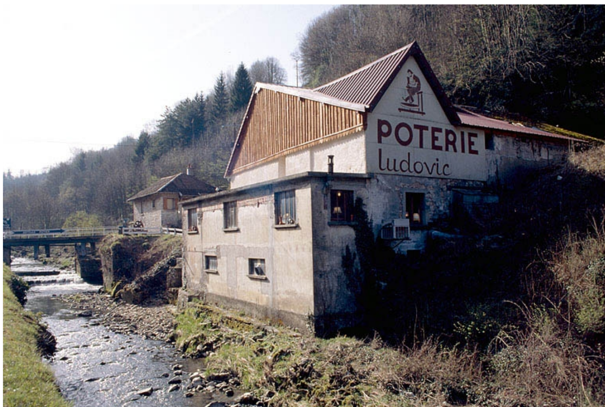
Bâtiment d'eau et atelier de fabrication.
