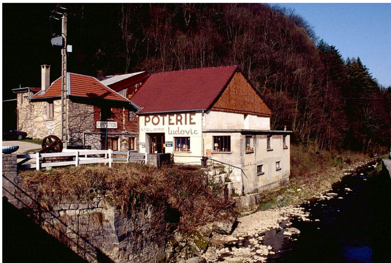
Atelier de fabrication depuis le pont.
