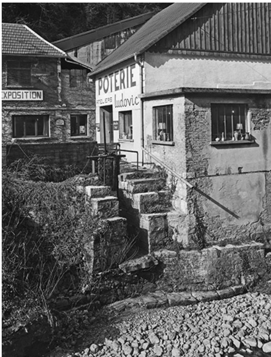
Vannage et déversoir du canal d'amenée.
