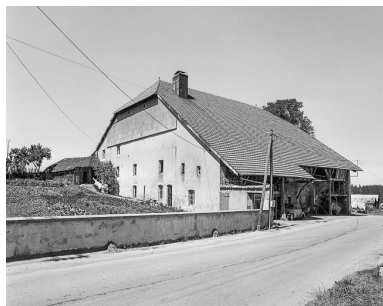
Ferme située 3 rue des Tourbières : vue d'ensemble de trois quarts gauche.. Phot. Dominique Dominguez IVR43_19792501008X
