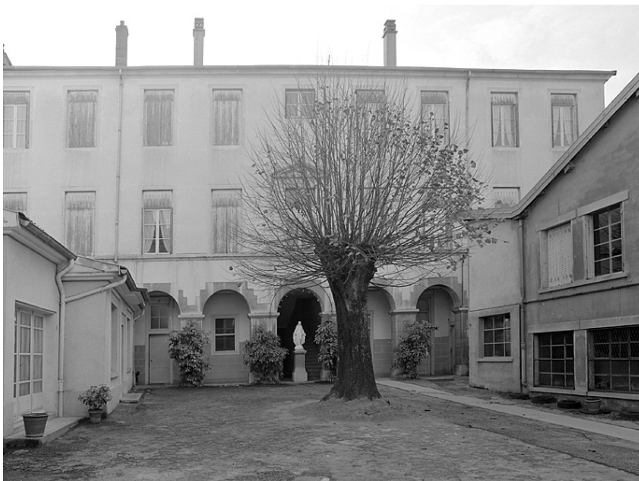
Bâtiment annexe, façade sur la cour.
