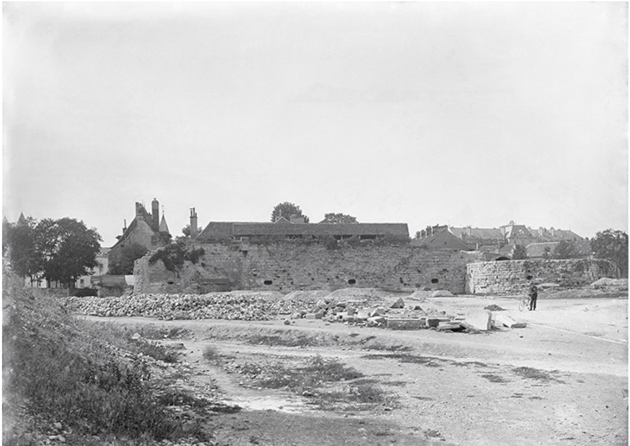
Démolition du château. [1890-1897].
