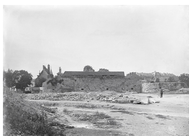
Démolition du château. [1890-1897]. Autr. auteur inconnu IVR26_20252100049NUC4A
