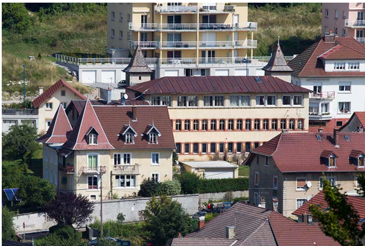
Vue d'ensemble plongeante, depuis le sud.
