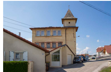
Usine : façade latérale droite.
