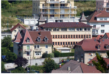
Vue d'ensemble plongeante, depuis le sud.
