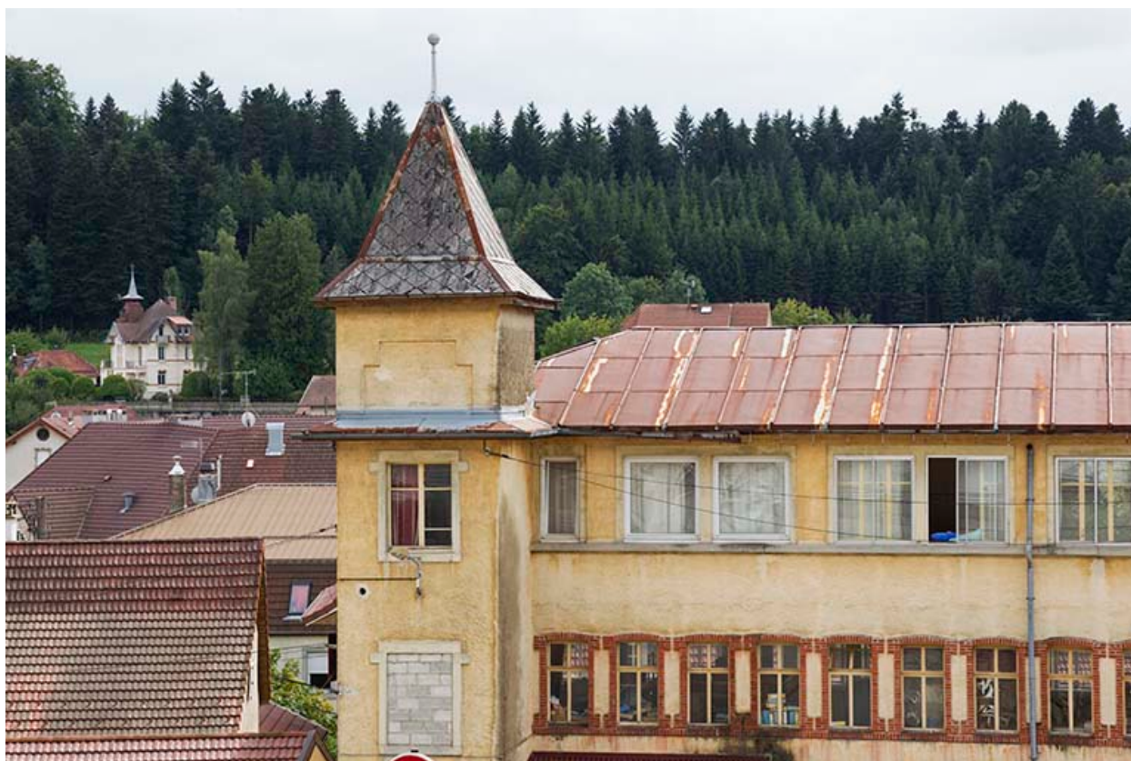
Usine, façade postérieure : tour orientale.
