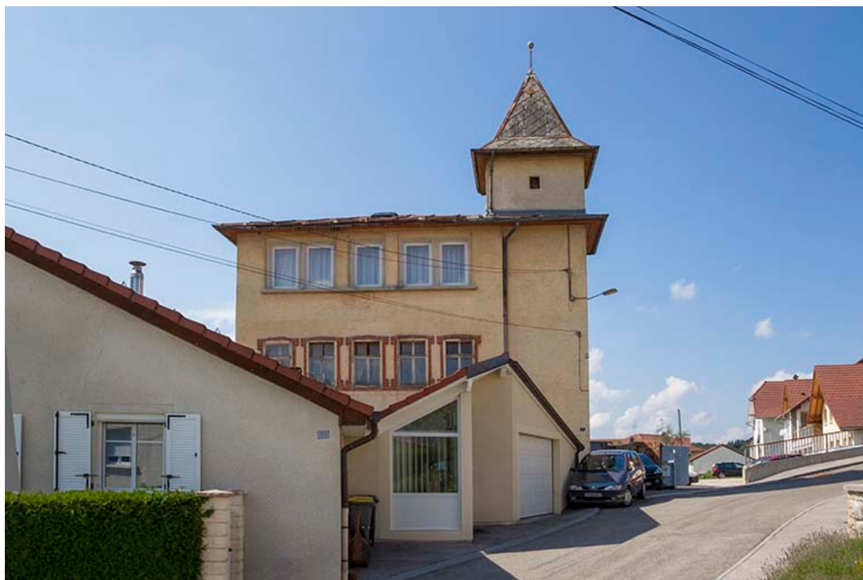
Usine : façade latérale droite.
