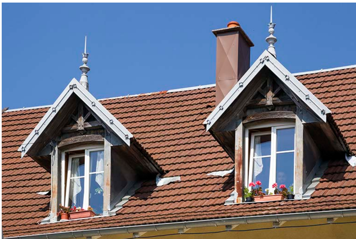
Logement patronal, façade latérale gauche : lucarnes.
