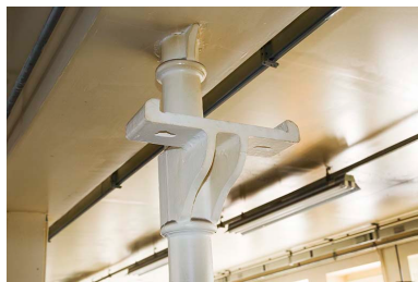
Usine, rez-de-chaussée : support des transmissions sur le poteau de soutènement. Phot. Yves Sancey IVR43_20132501846NUC2A
