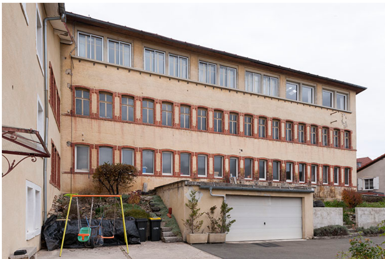
Usine : façade antérieure (sud).
