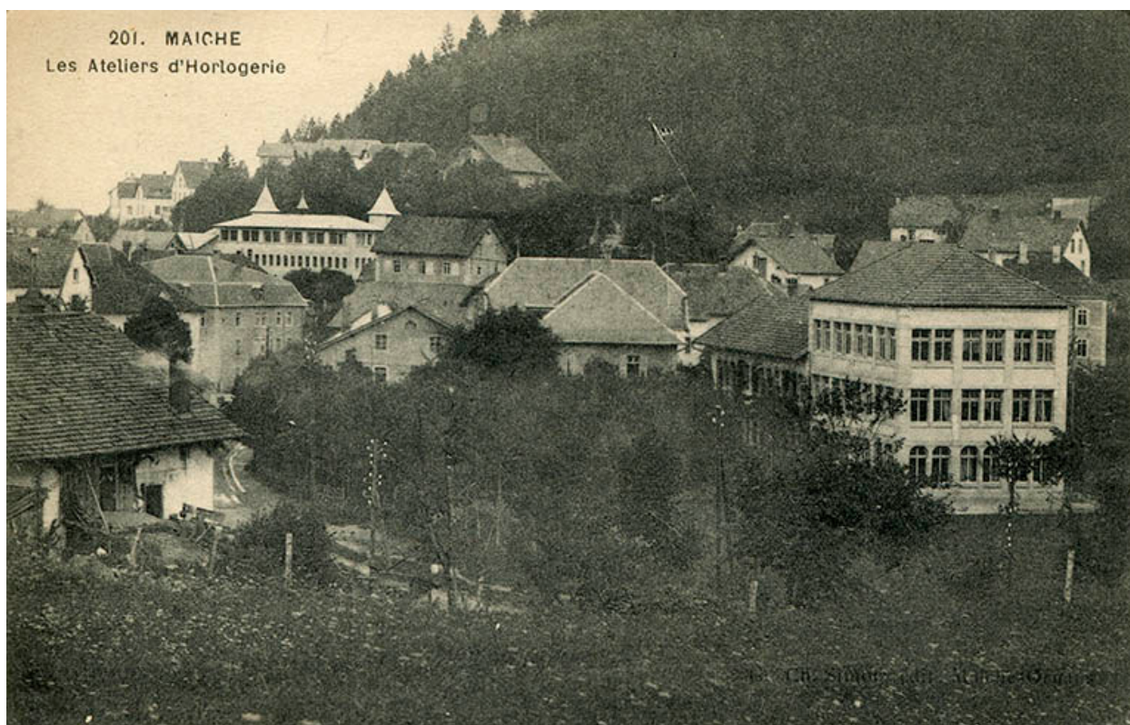
201. Maîche. Les ateliers d'horlogerie, entre 1914 et 1918.
