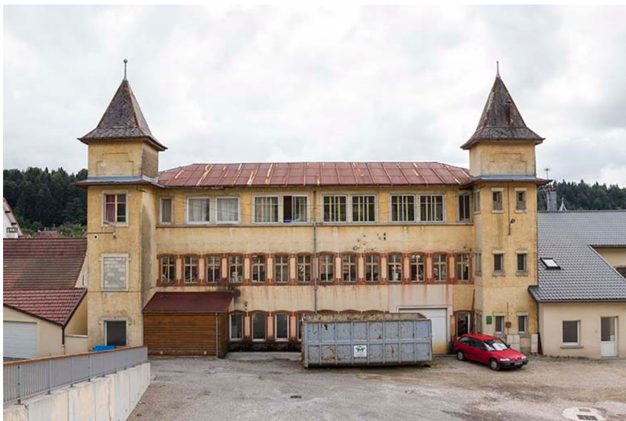
Usine : façade postérieure.
