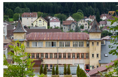
Usine : façade postérieure, vue en plongée.
