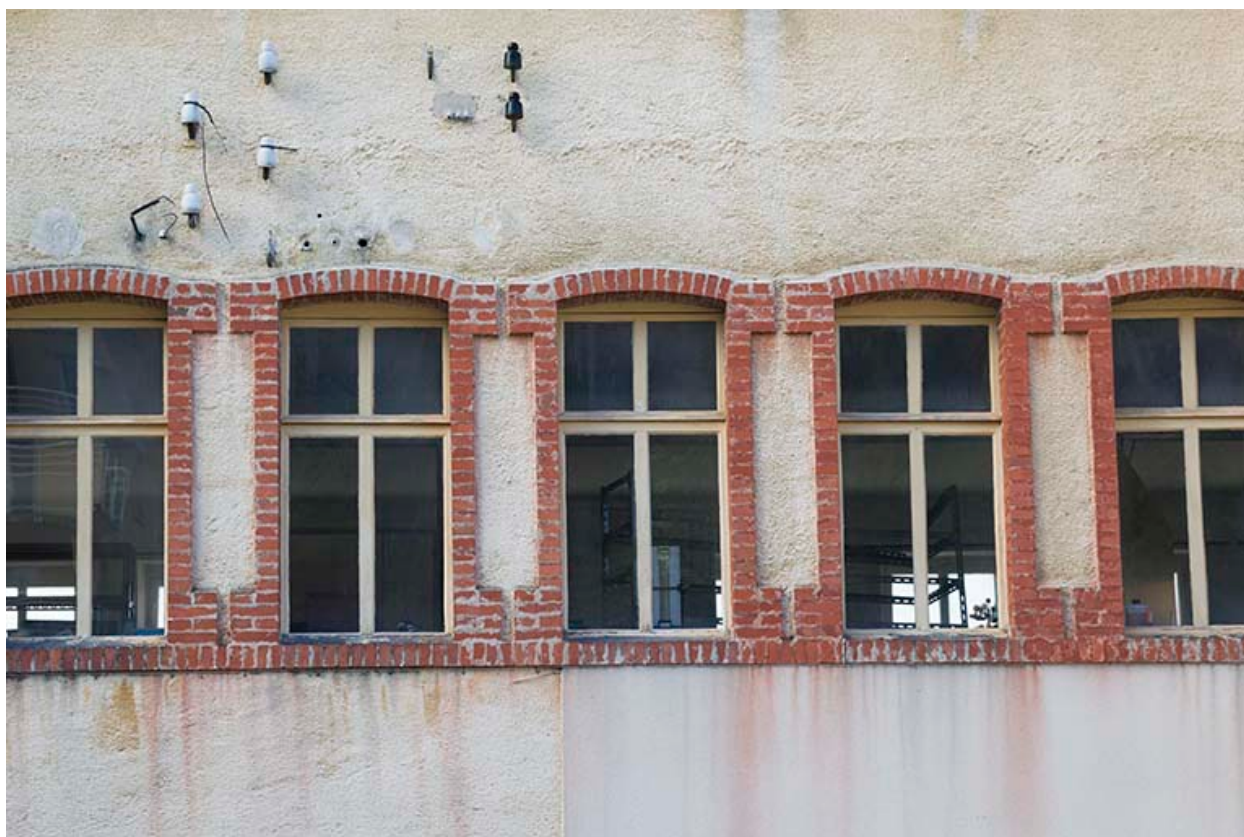
Usine, façade postérieure : fenêtres multiples.
