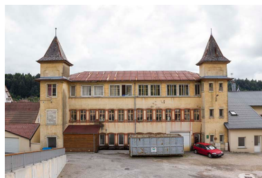
Usine : façade postérieure.
