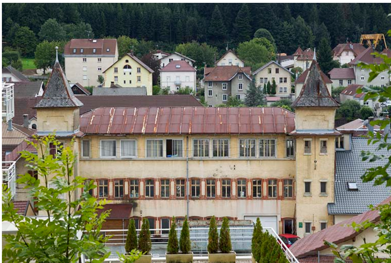
Usine : façade postérieure, vue en plongée.
