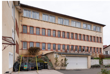
Usine : façade antérieure (sud).
