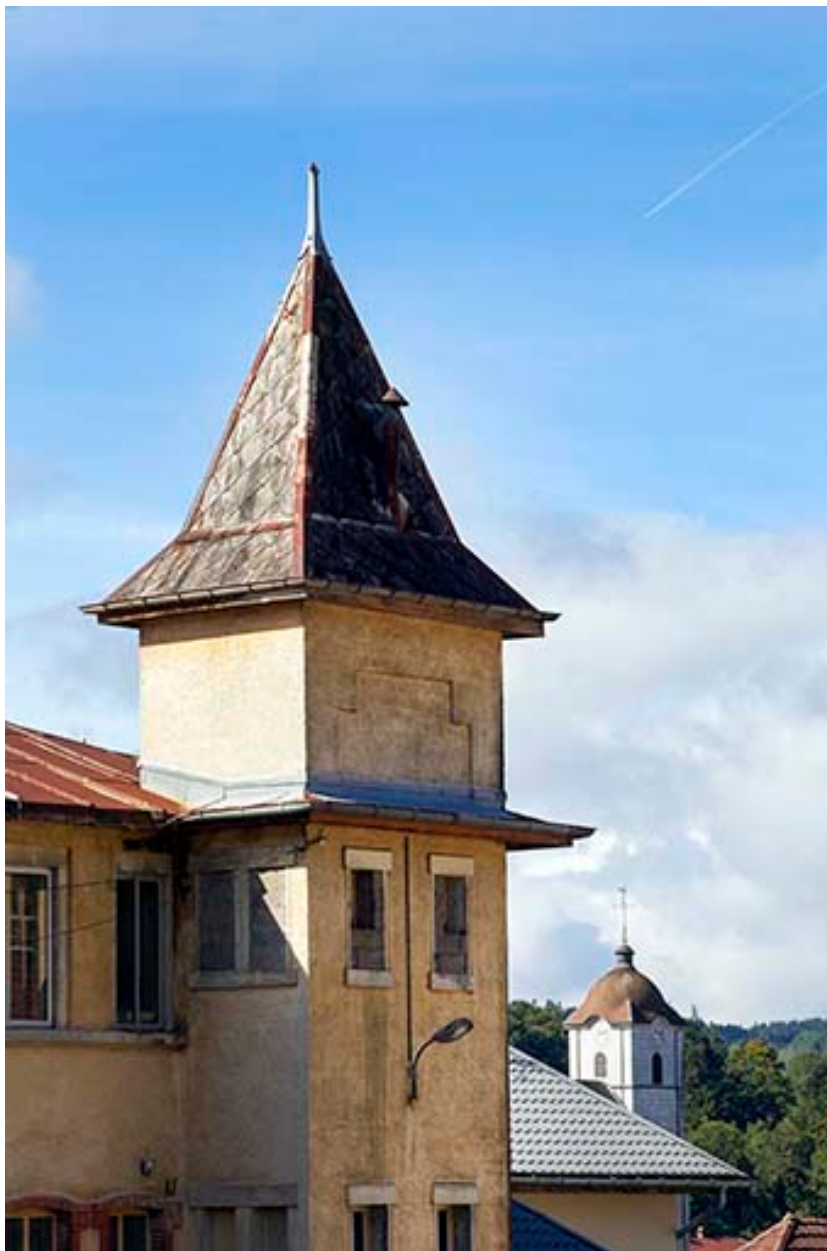
Usine, façade postérieure : tour occidentale (vue rapprochée).
