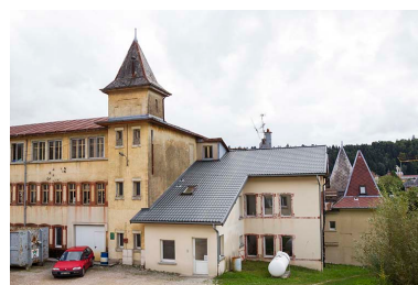
Atelier : façade nord.
