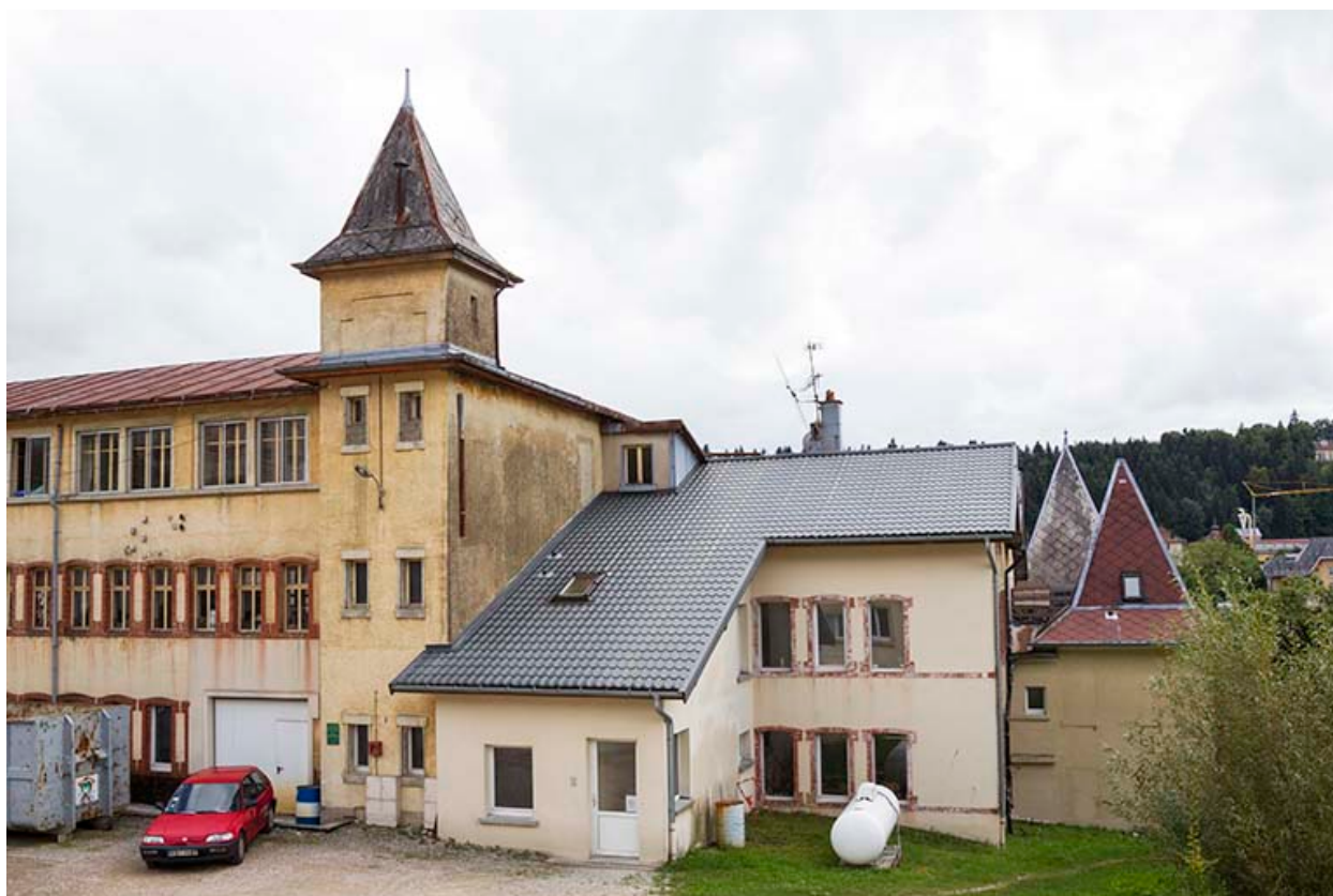
Atelier : façade nord.
