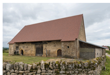
Vue de la grange, depuis le sud Phot. Pierre-Marie Barbe-Richaud IVR26_20187100175NUC4A
