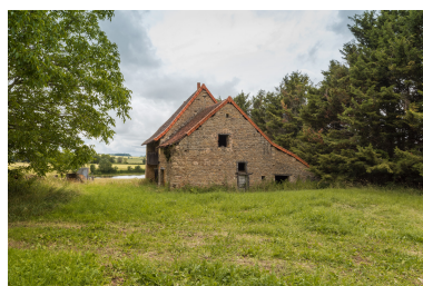
vue de la ferme depuis le nord- est, et du mur-pignon de la dépendance construite contre la maison au XIXe siècle et abritant une étable surmontée d'un fenil. Phot. Pierre-Marie Barbe-Richaud IVR26_20187100209NUC4A
