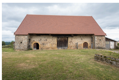
Vue frontale de la grange Phot. Pierre-Marie Barbe-Richaud IVR26_20187100177NUC4A
