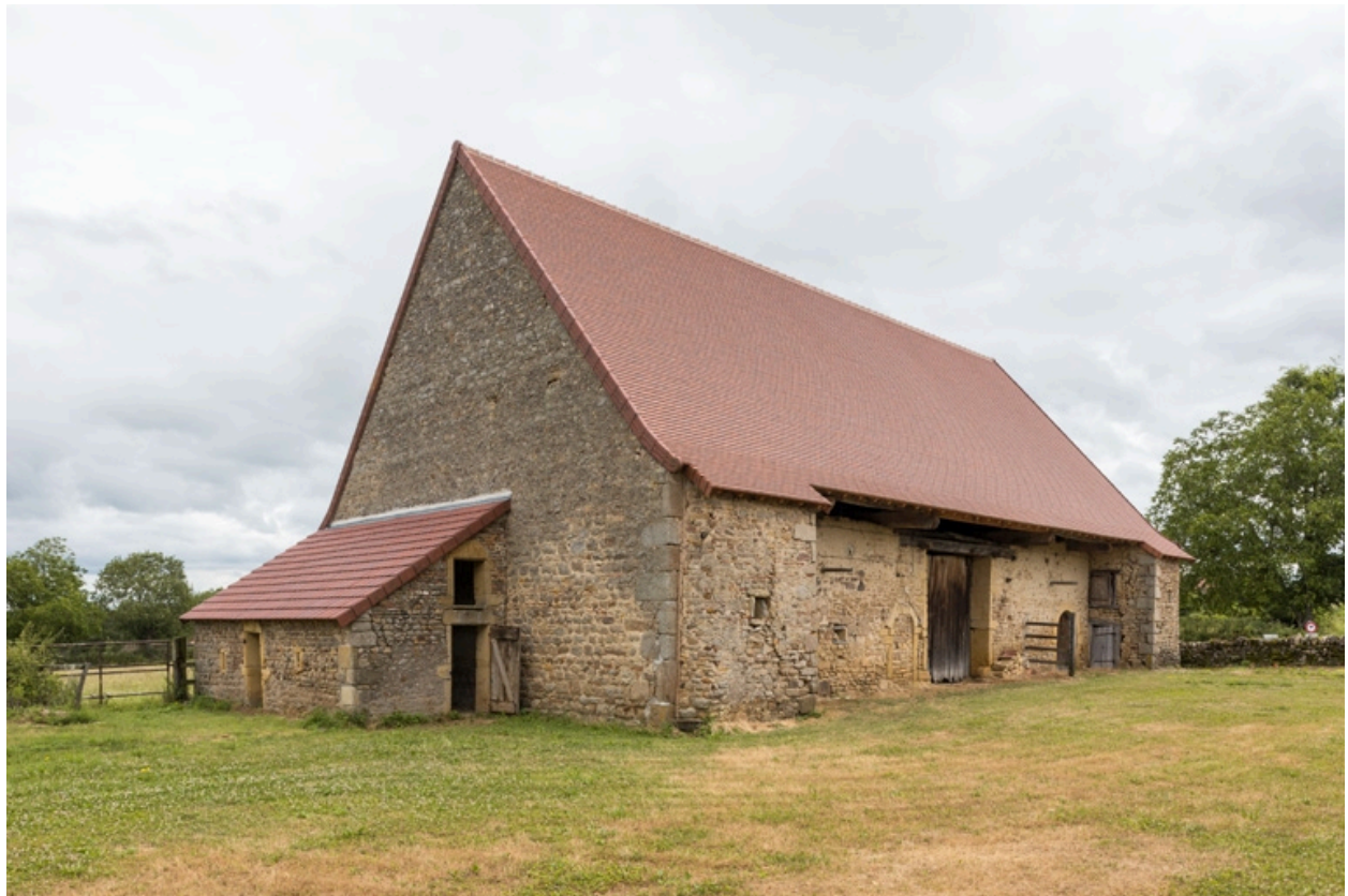
Vue de la grange, depuis l'ouest
