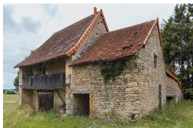
Vue de la ferme, depuis l'est. Phot. Pierre-Marie Barbe-Richaud IVR26_20187100208NUC4A
