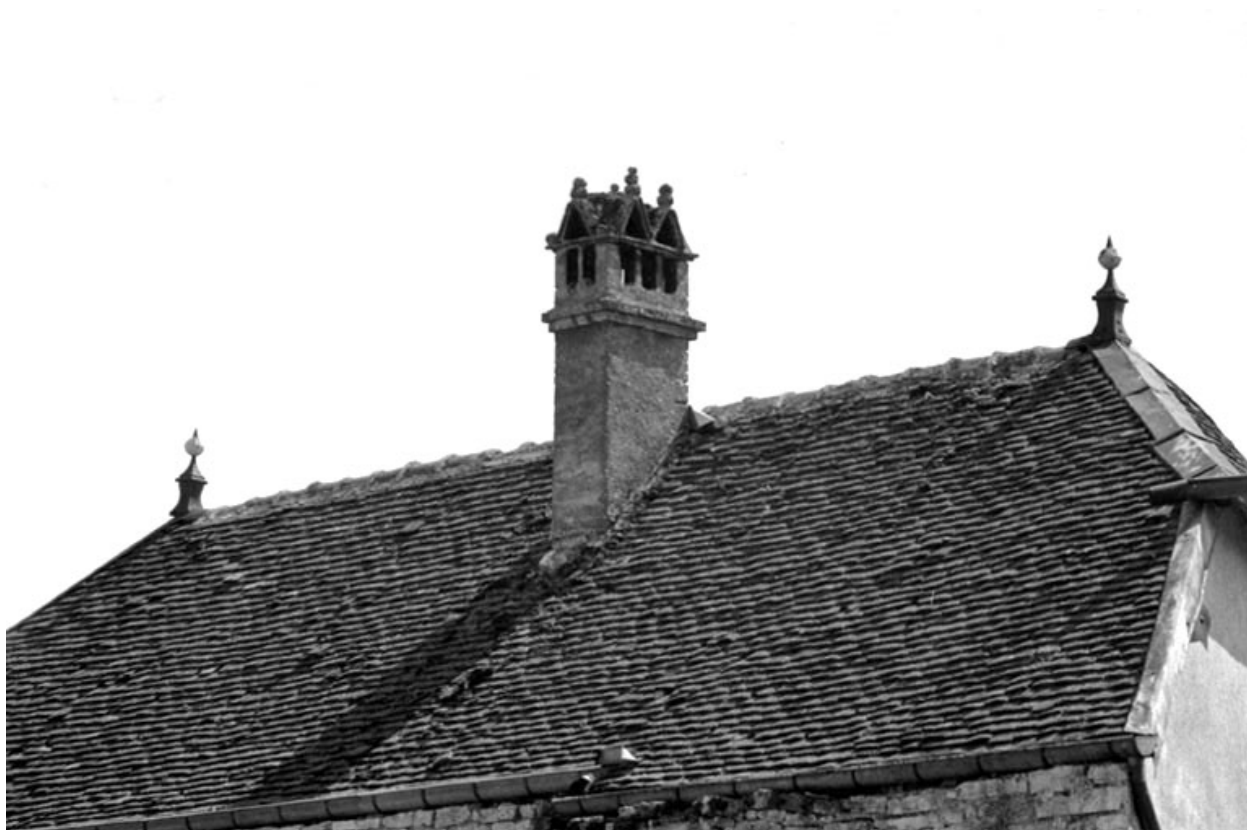
Détail du toit recouvert de tuiles plates
