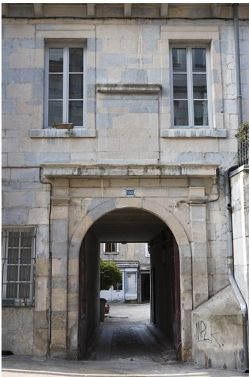
Vue d'ensemble du portail d'entrée.
