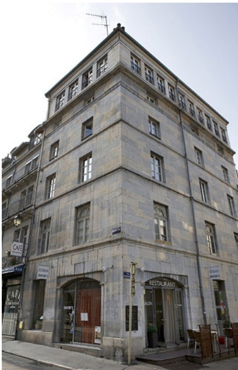
Vue d'ensemble de l'immeuble d'angle.
