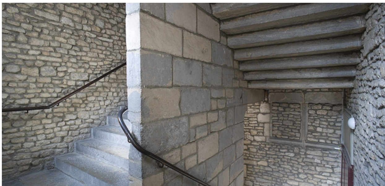
Détail de l'escalier principal en maçonnerie.
