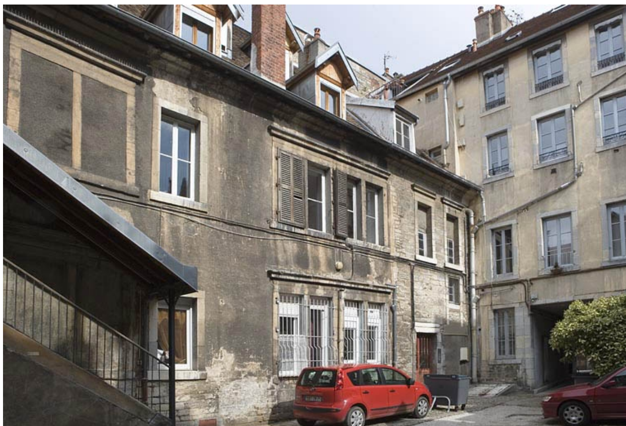
Vue d'ensemble de l'aile sur cour.
