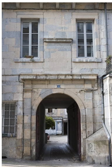
Vue d'ensemble du portail d'entrée. Phot. Yves Sancey IVR43_20092501260NUC2A
