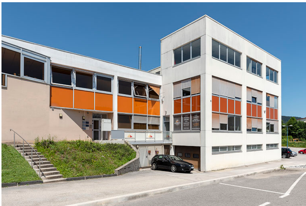
Façade est, de trois quarts gauche.
