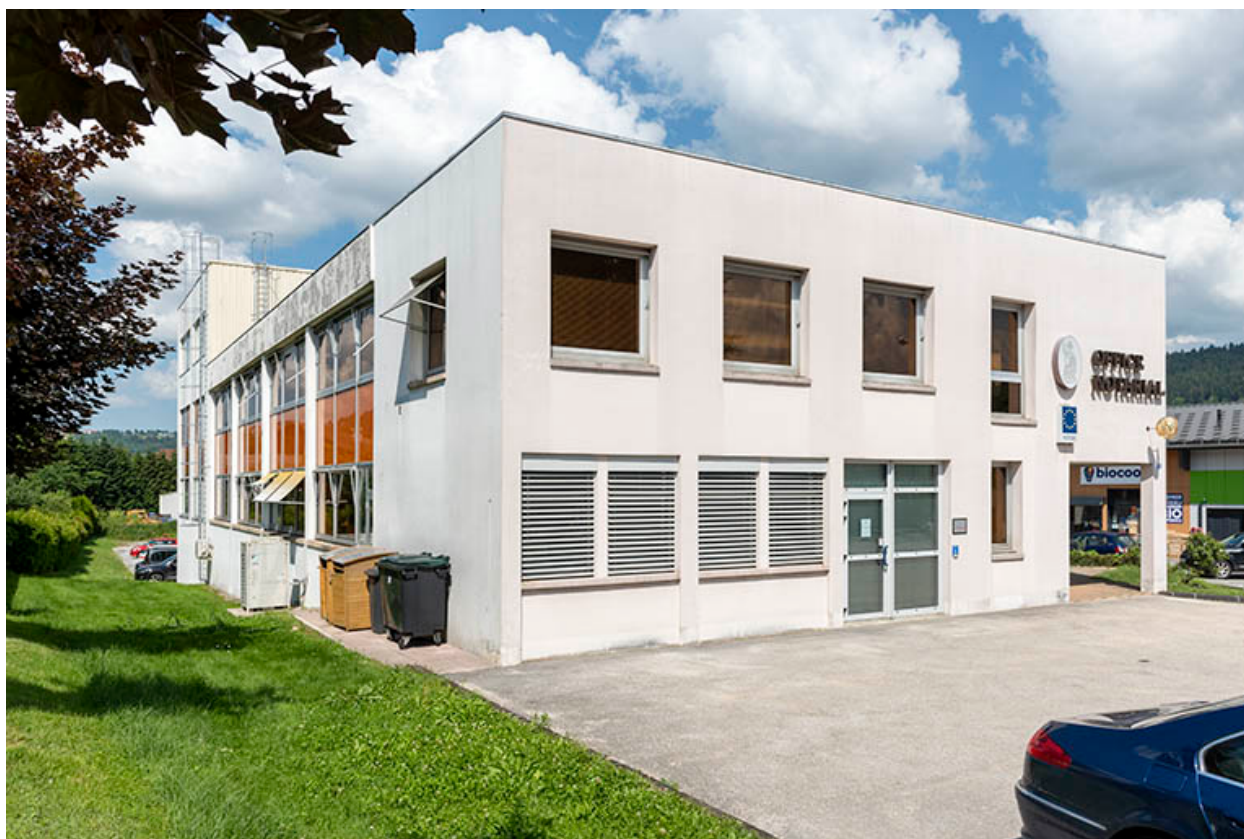
Façade sud, de trois quarts gauche.
