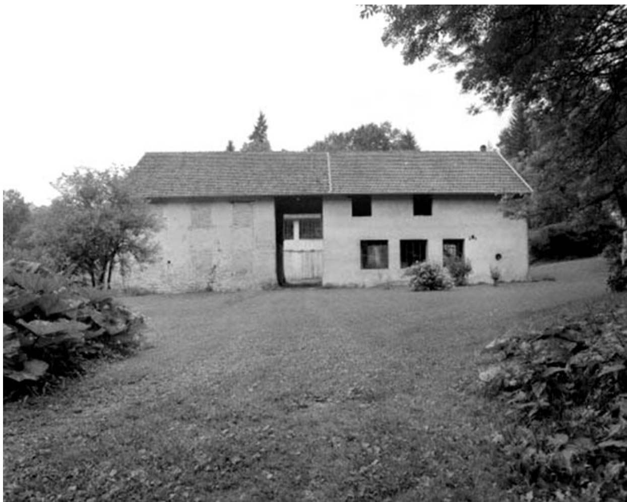
Façade postérieure de l'atelier de fabrication sud.
