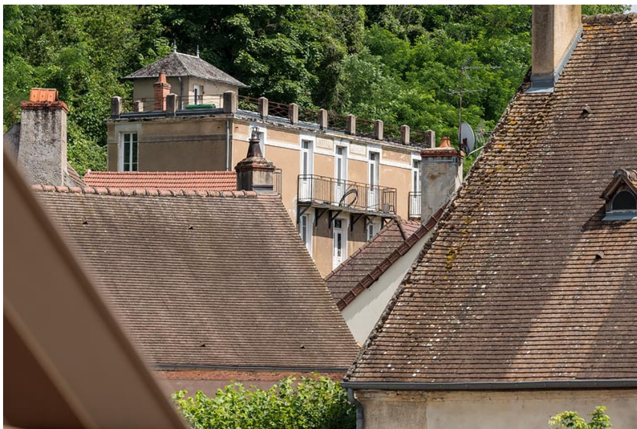
Façade de l'extension ("annexe").
