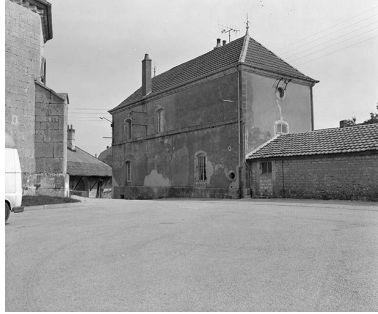
Façade postérieure. Phot. Yves Sancey IVR43_19802500883X
