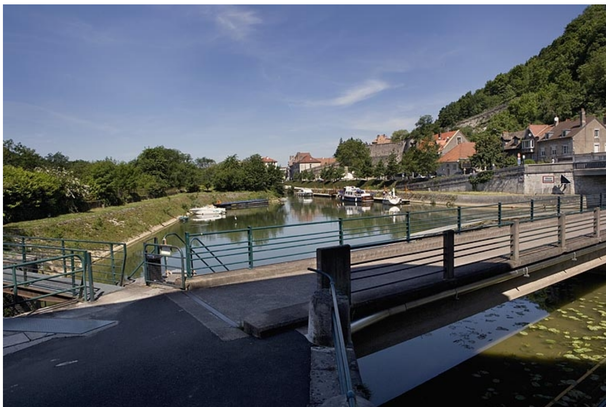
Vue d'ensemble depuis l'écluse n° 51.
