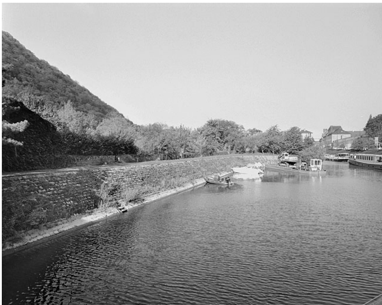
Perré sud (côté île).
