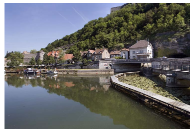
Debouché de l'écluse n ° 50, pont routier et estacade, depuis l'écluse n° 51. Phot. Yves Sancey IVR43_20062500218NUCA
