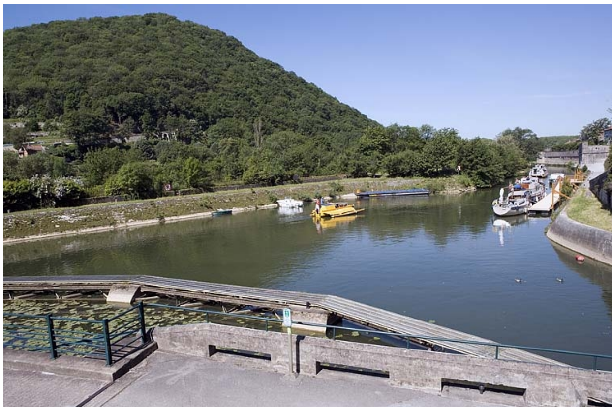
Bassin, depuis la route à l'est.
