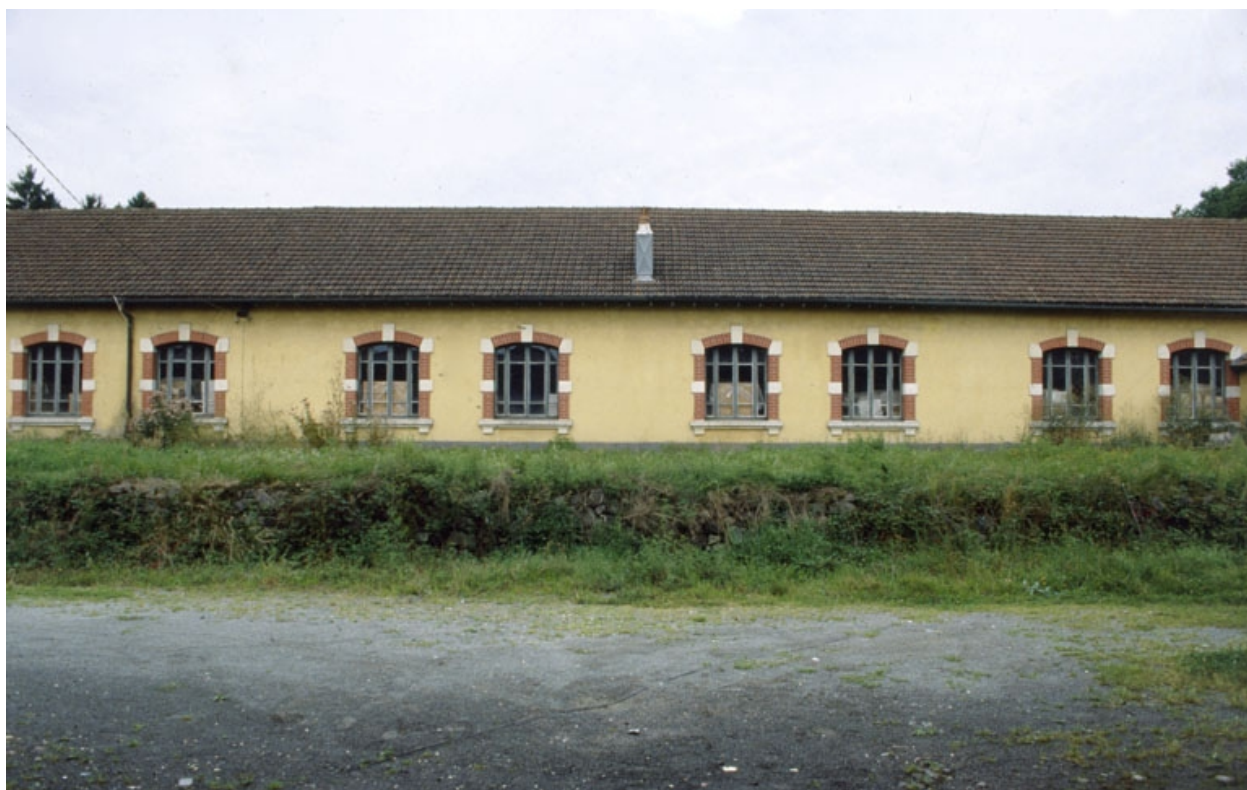
Façade sud de l'atelier de tissage.
