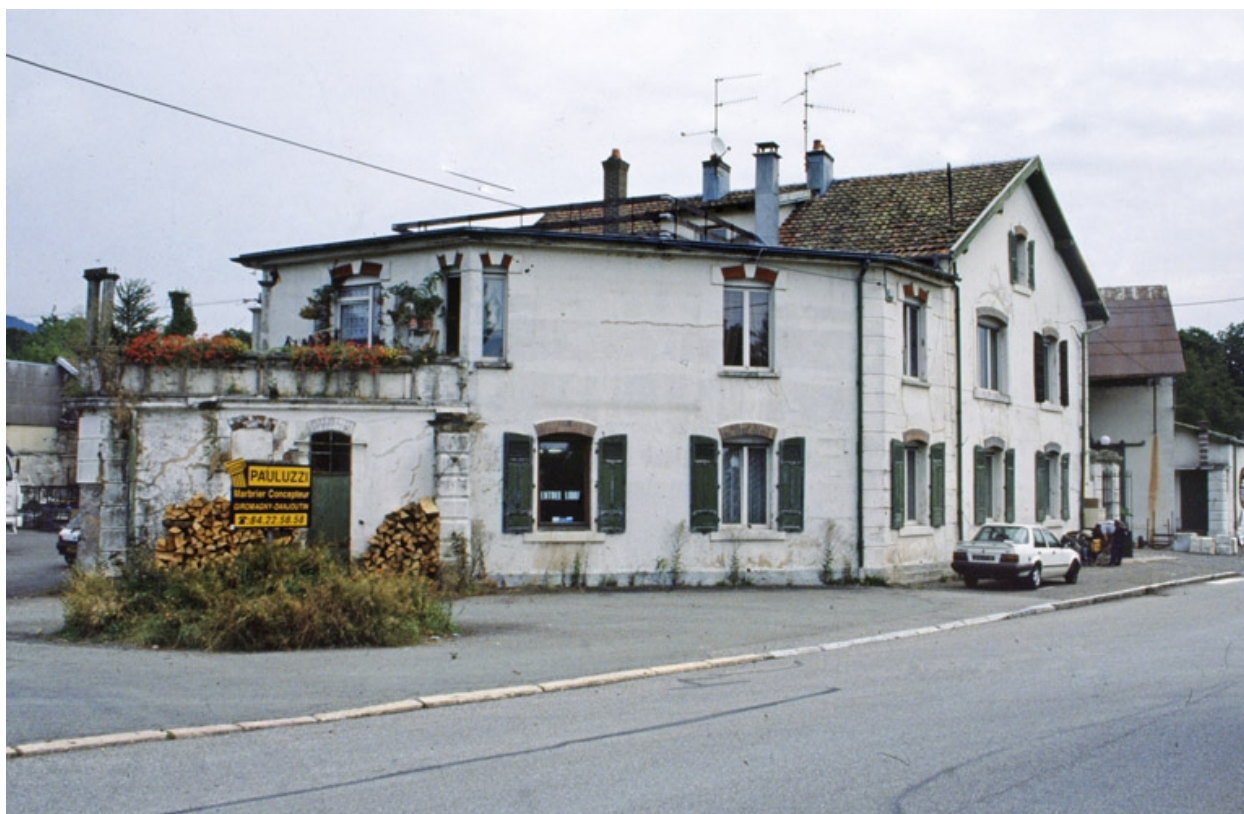
Vue d'ensemble depuis l'avenue de Schwabmünchen.
