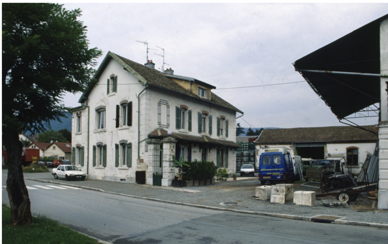
Vue d'ensemble de l'entrée.
