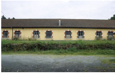
Façade sud de l'atelier de tissage.
