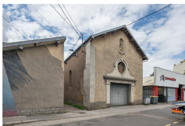
Façade antérieure. Vue d'ensemble. Phot. Pierre-Marie Barbe-Richaud IVR43_20222500136NUC4A
