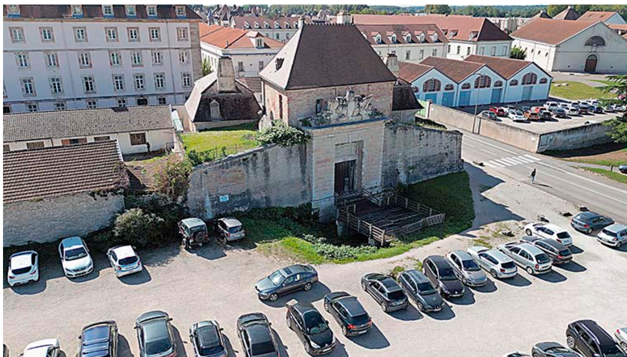
Vue aérienne de la porte.
