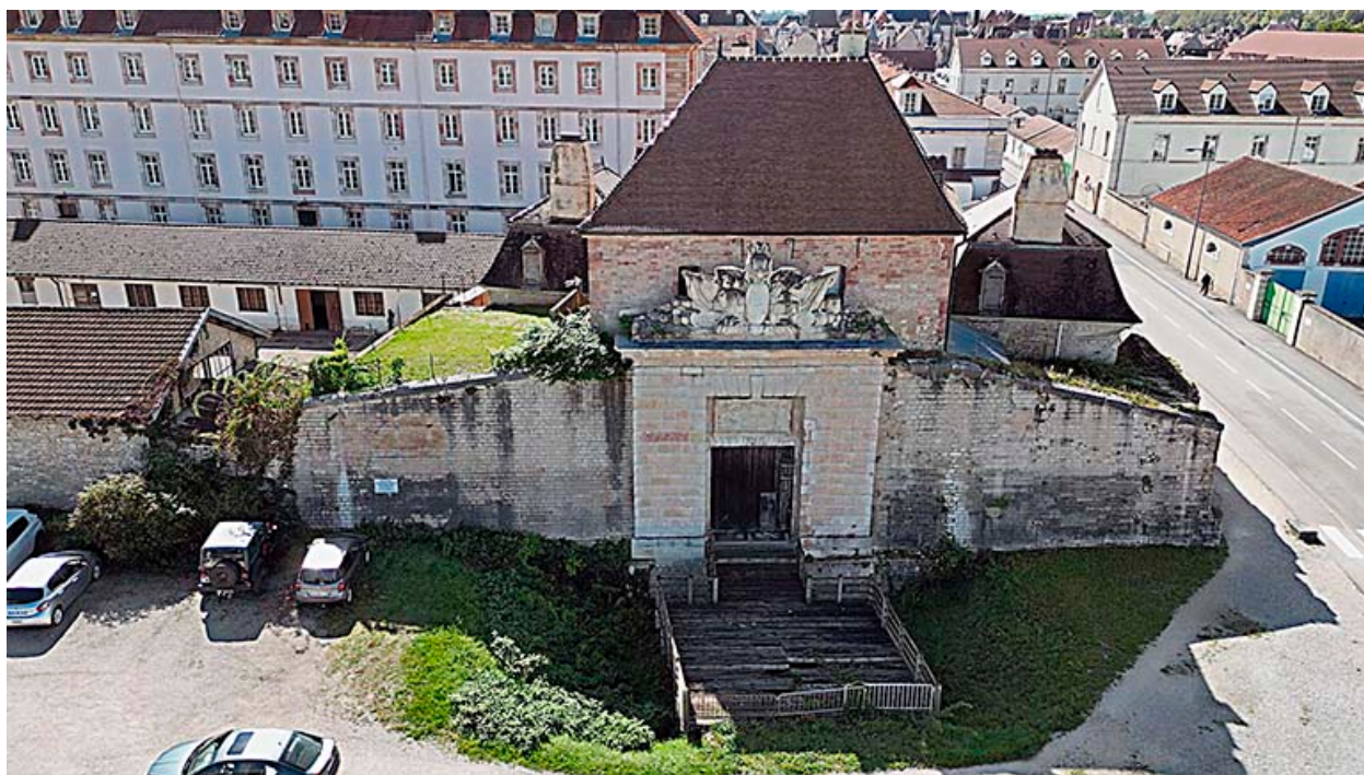
Vue aérienne de la porte.
