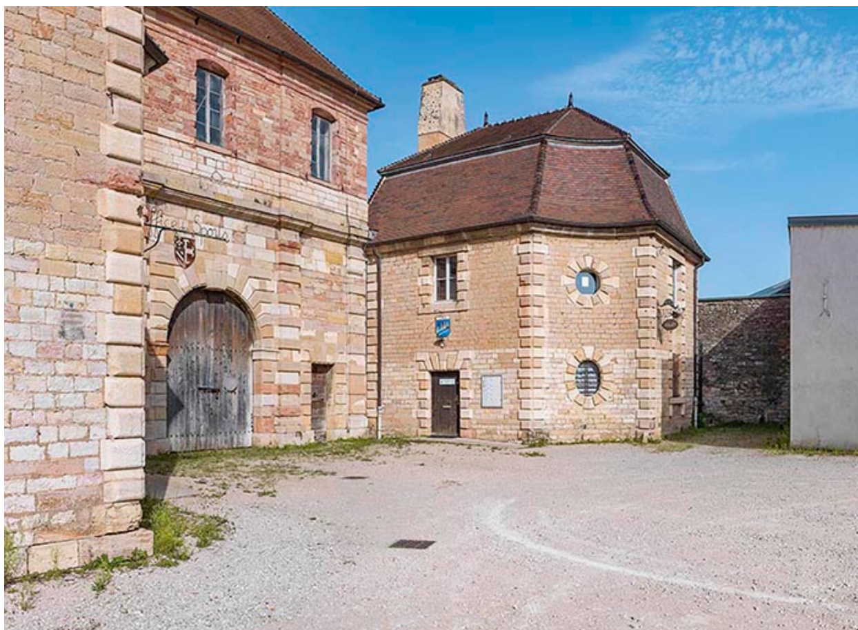
L'entrée cochère et un des pavillons.
