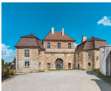
Vue générale. Phot. Thierry Kuntz IVR26_20232100516NUC4A
