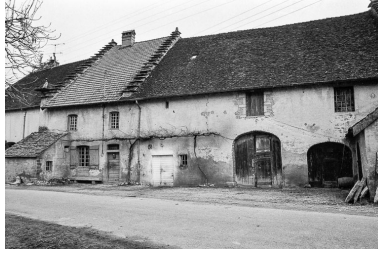
Façade antérieure en 1974. Phot. F. Pernin IVR43_19743900034Z
