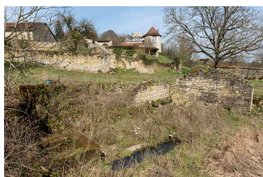
Ancien lavoir de Richecourt. Phot. Sonia Dourlot IVR43_20167000593NUC4A
