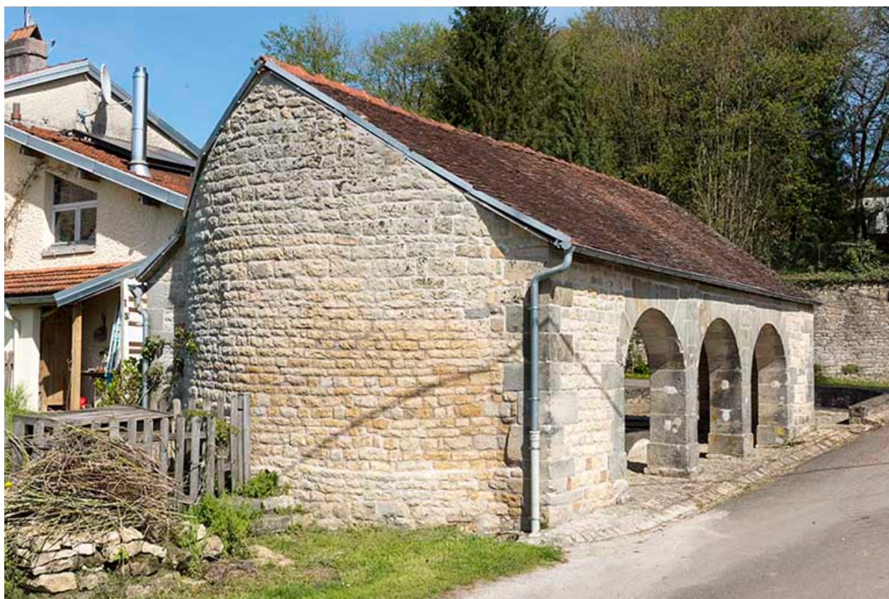
Mur pignon du lavoir.
