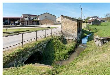
Vue générale du lavoir, Grande rue. Phot. Sonia Dourlot IVR43_20167000521NUC4A
