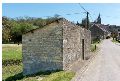
Le lavoir avec l'église en arrière plan. Phot. Sonia Dourlot IVR43_20167000522NUC4A
