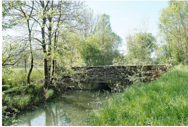
Pont ancien modifié. Phot. Jean-Luc Duthu IVR26_20107100551NUC2A
