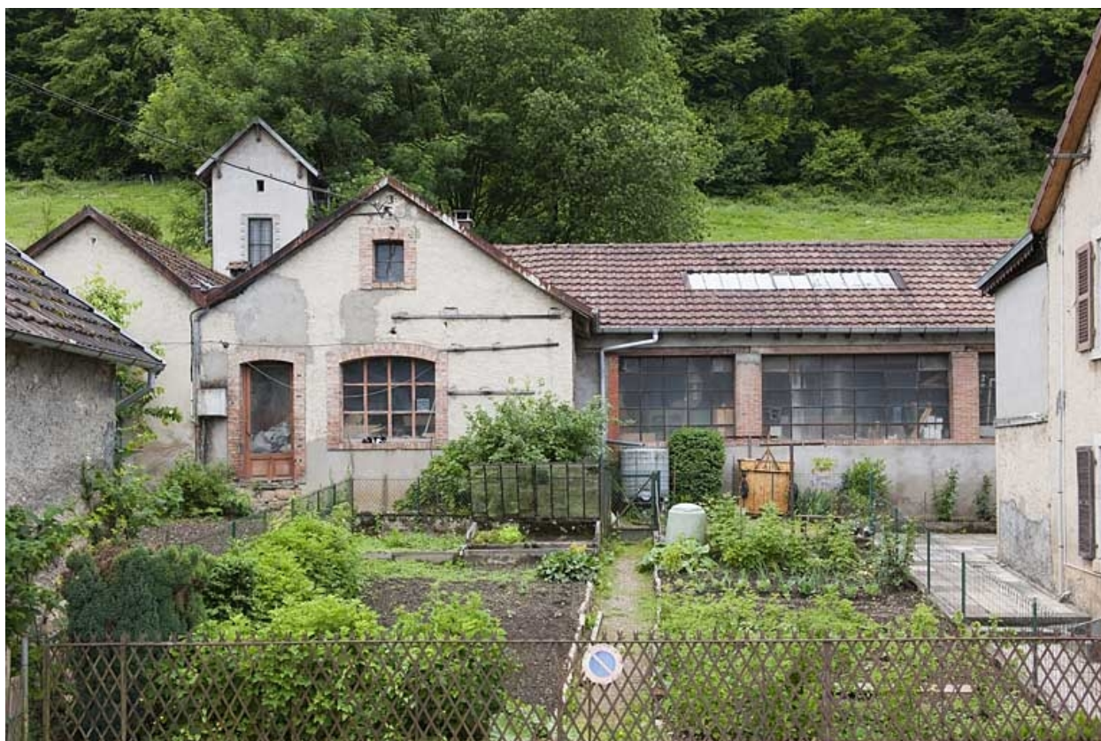
Extrémité sud de l'atelier.
