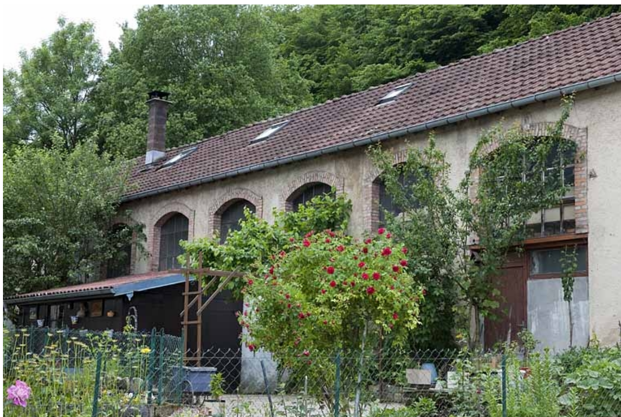
Façade est de l'atelier.
