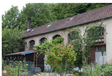
Façade est de l'atelier. Phot. Jérôme Mongreville IVR43_20122501048NUC4A
