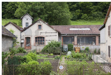
Extrémité sud de l'atelier. Phot. Jérôme Mongreville IVR43_20122501050NUC4A
