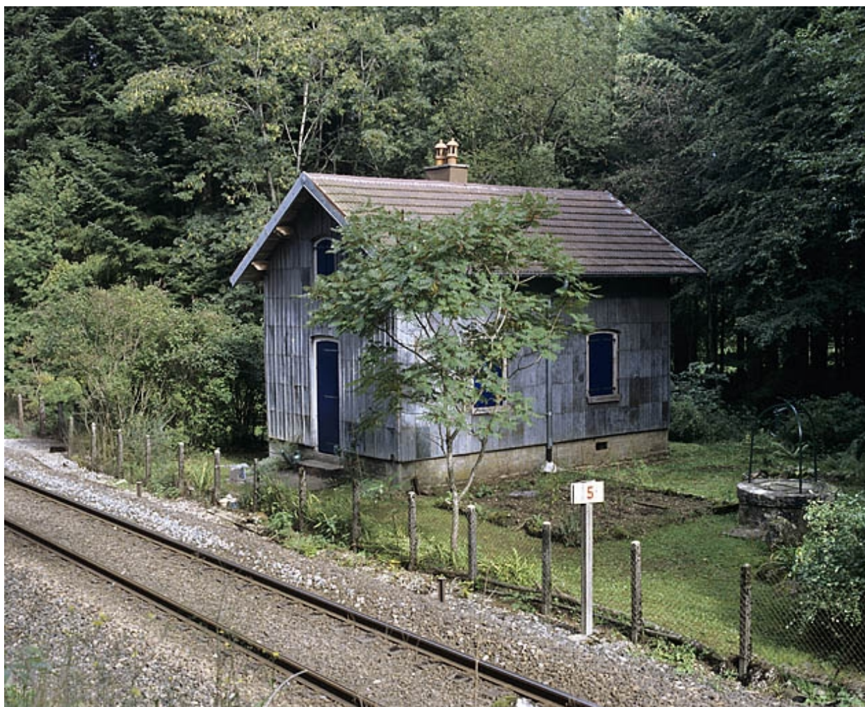
Façades antérieure et latérale droite.
