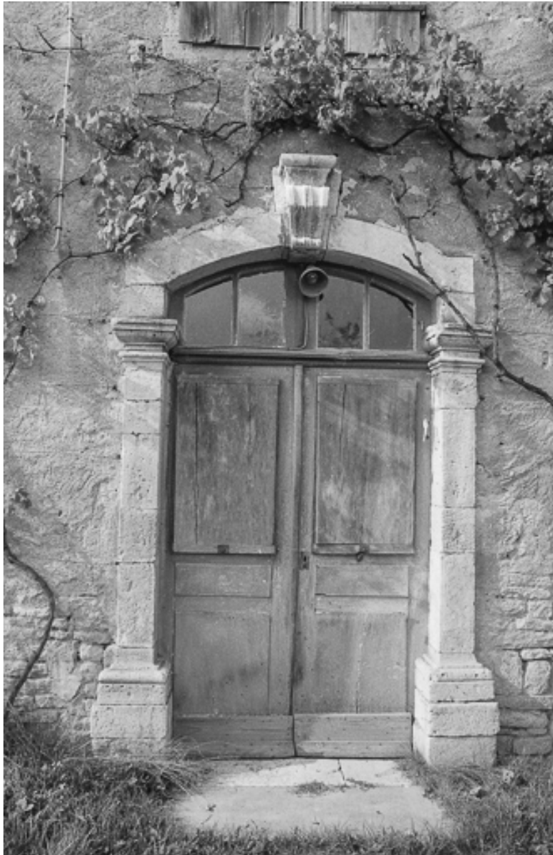
Détail : porte d'entrée de l'habitation.
