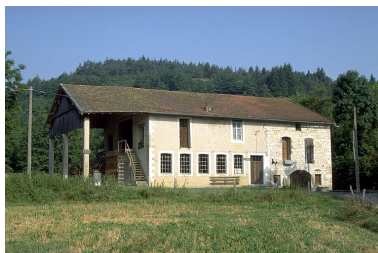
Façade antérieure. Phot. Laurent Poupard IVR43_19923901206ZA
