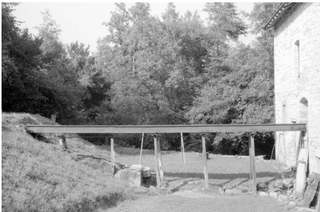
Conduite d'amenée de la roue.
