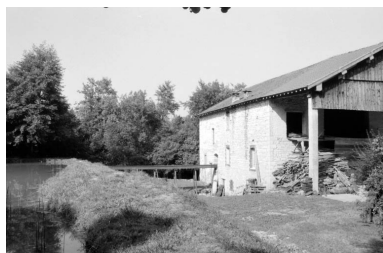
Façade postérieure et conduite d'amenée de la roue. Phot. Laurent Poupard IVR43_19923901208Z
