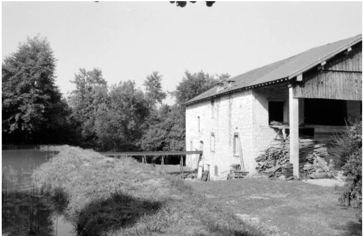
Façade postérieure et conduite d'amenée de la roue.
