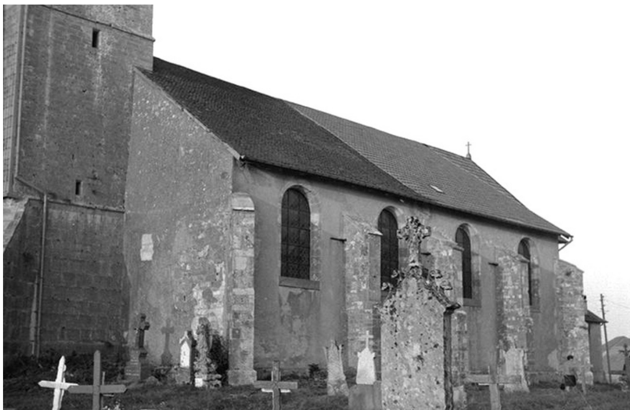
Façade latérale droite et cimetière.
