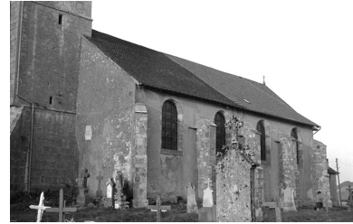
Façade latérale droite et cimetière. IVR43_19692500038Z
