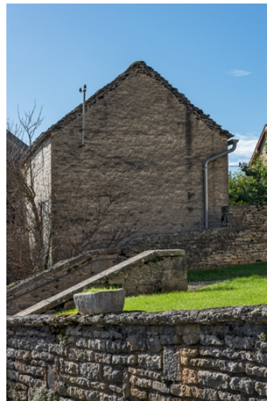
Vue du mur pignon nord. Phot. Pierre-Marie Barbe-Richaud IVR26_20222100972NUC4A
