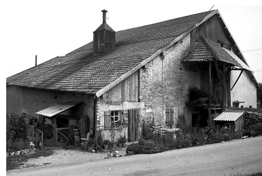
Ferme située 3 rue du Chalet. Phot. Gilbert Poinot IVR43_19762500814Z
