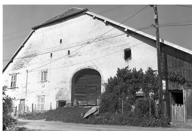
Ferme située 7 rue du Noyer : vue d'ensemble. Phot. Yves Sancey IVR43_19802501196X
