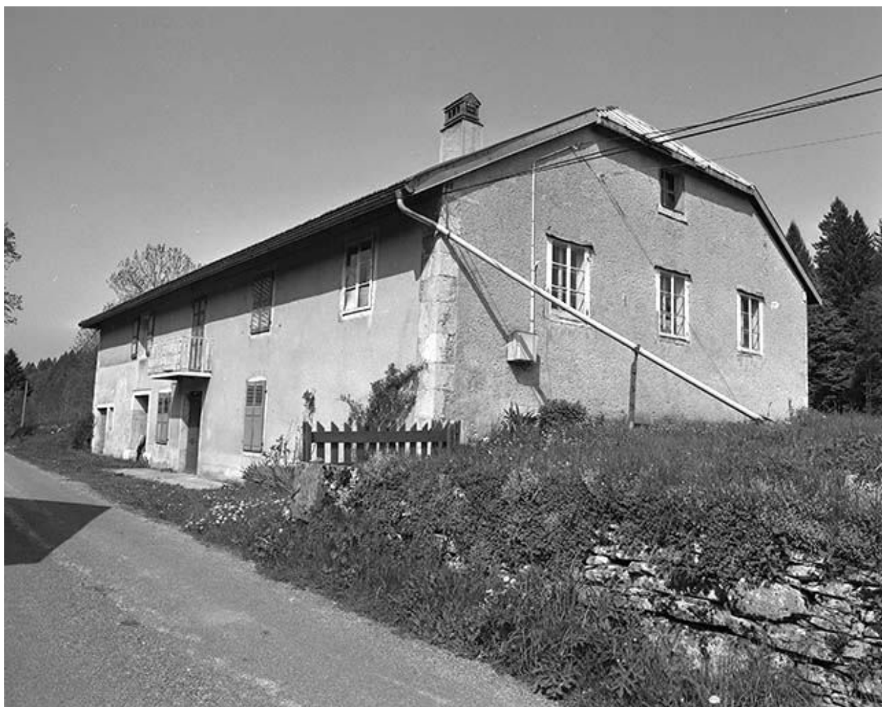
Façade antérieure et face droite.
