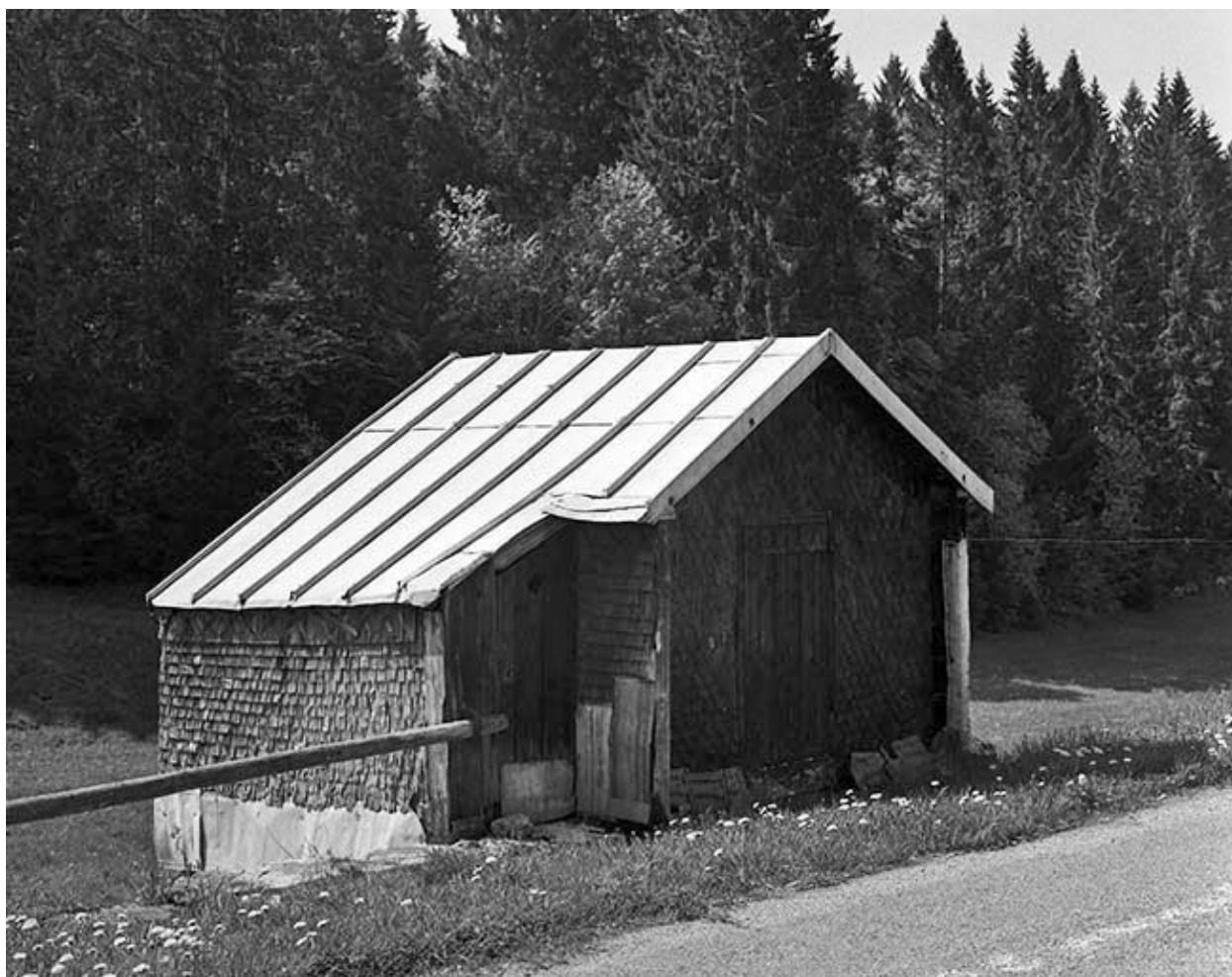
Resserre, appelée " grenier fort ".
