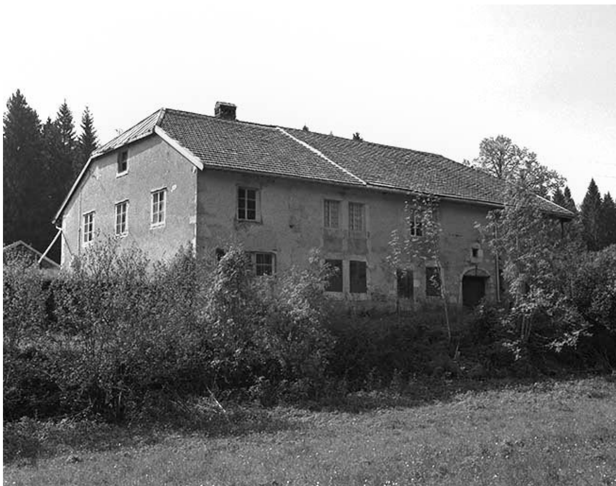
Façade postérieure vue de trois quarts gauche.
