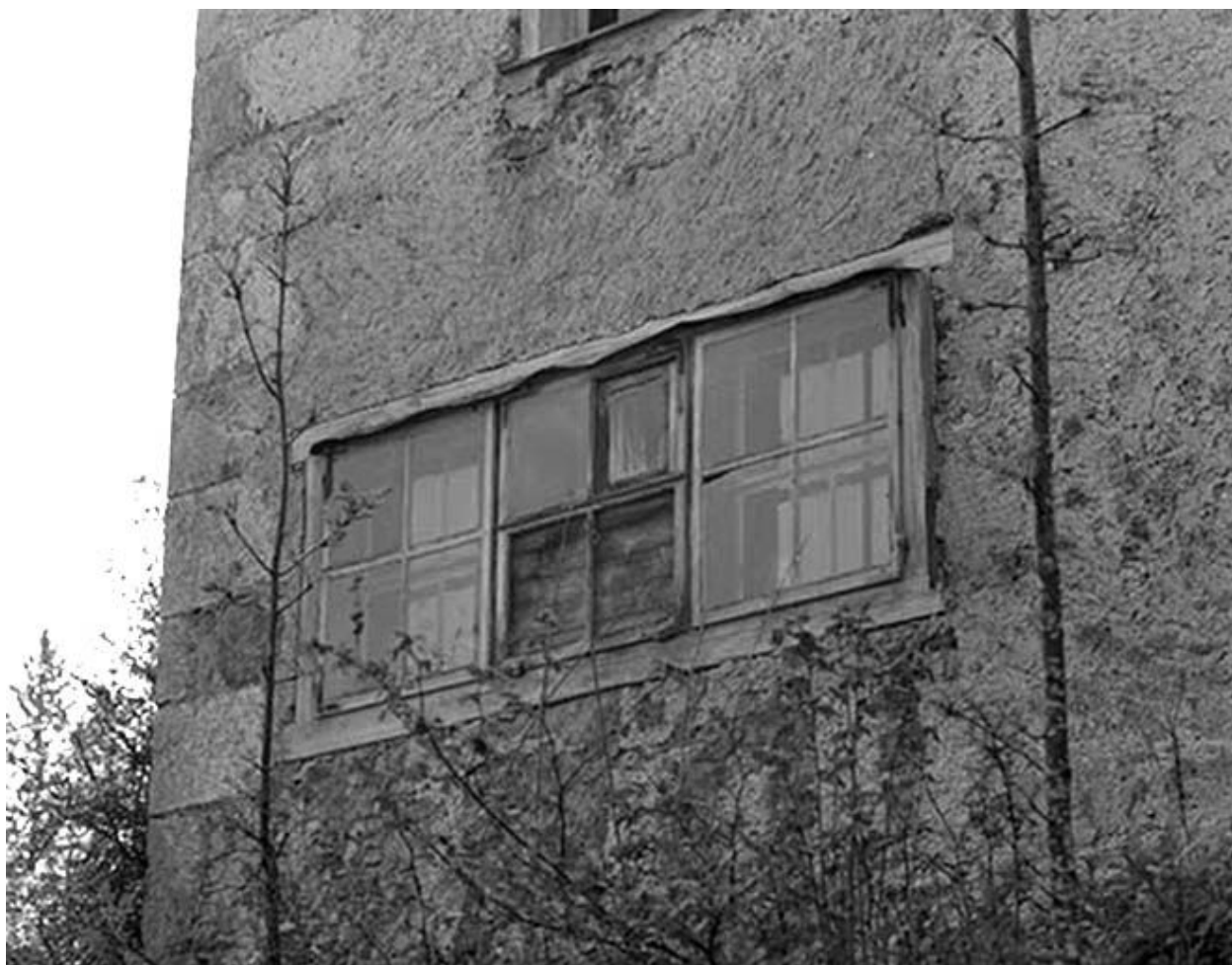
Fenêtre triple sur la façade postérieure.
