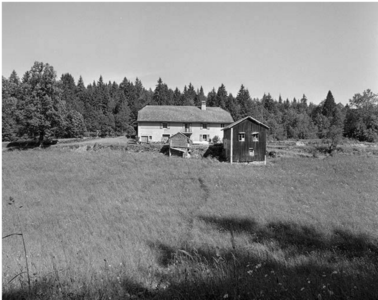
Façade antérieure, vue éloignée.
