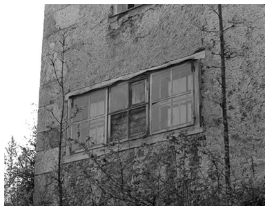
Fenêtre triple sur la façade postérieure. Phot. Jérôme Mongreville IVR43_20013900557X
