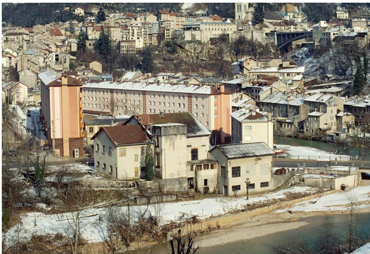
Vue d'ensemble rapprochée depuis l'ouest.
