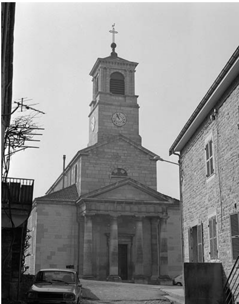
Extérieur : façade antérieure.
