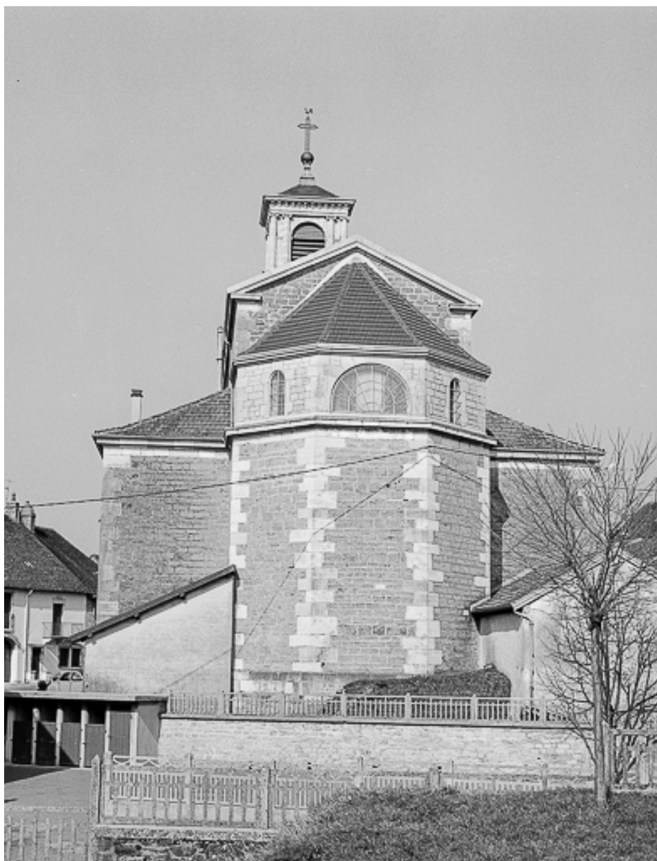
Extérieur : abside vue de face.
