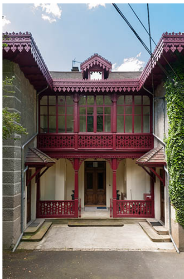
Façade est. Détail de l'entrée. Phot. Jérôme Mongreville IVR43_20132500673NUC4A
