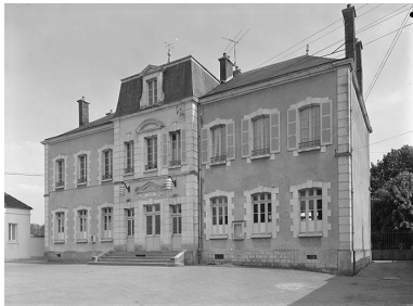
Façade sur rue. Phot. Michel Thierry IVR26_19748900039V
