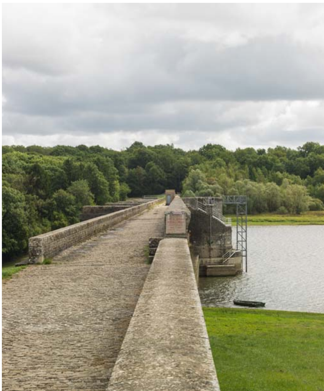
Vue rapprochée du barrage.
