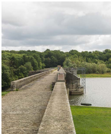
Vue rapprochée du barrage. Phot. Pierre-Marie Barbe-Richaud IVR26_20172100581NUC2A
