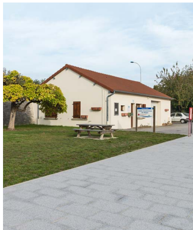
Vue d'ensemble de la maison de garde.
