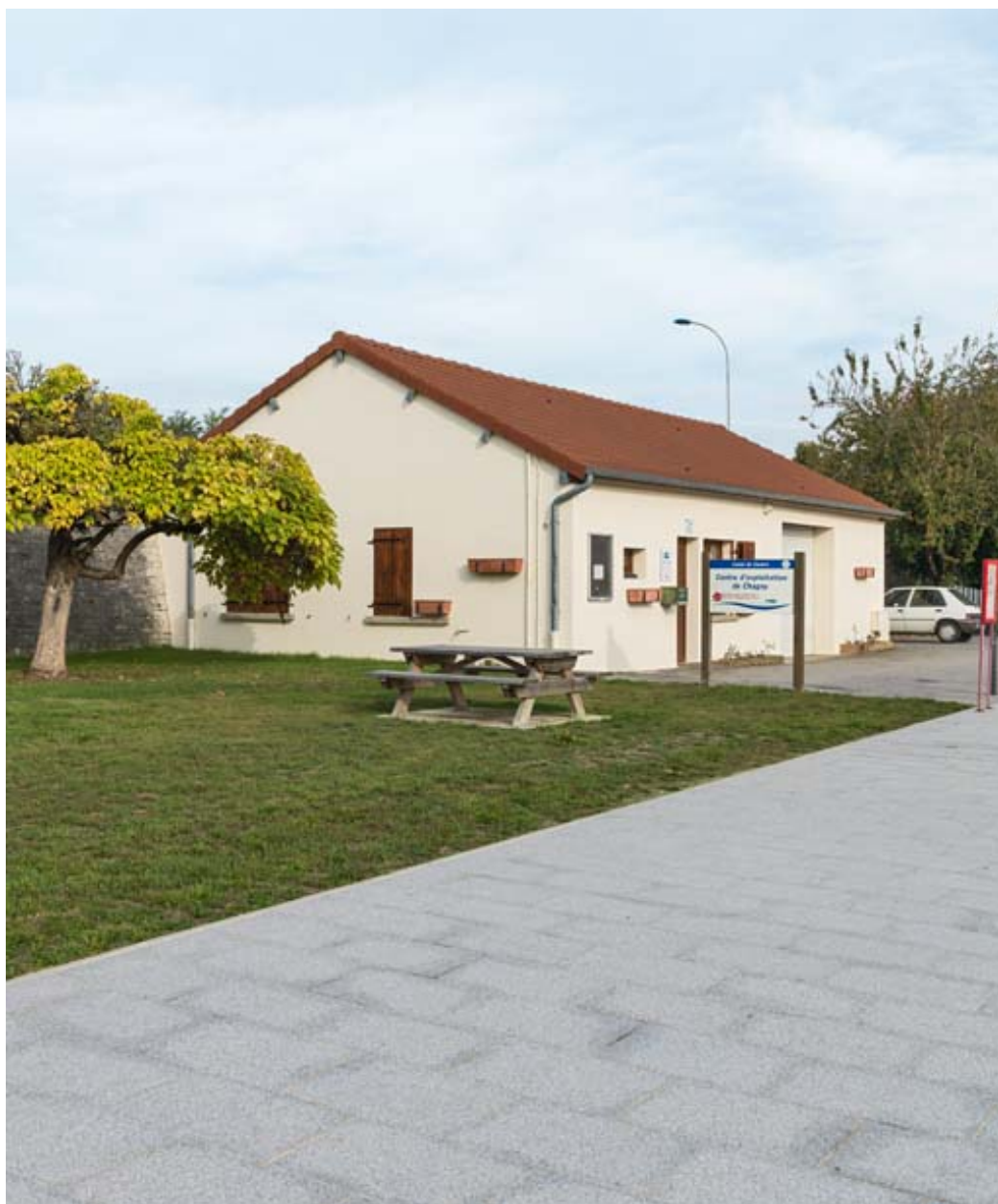
Vue d'ensemble de la maison de garde.
