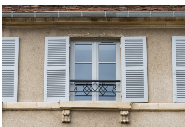
Façade antérieure : fenêtre du 2e étage. Phot. Pierre-Marie Barbe-Richaud IVR26_20232100069NUC4A
