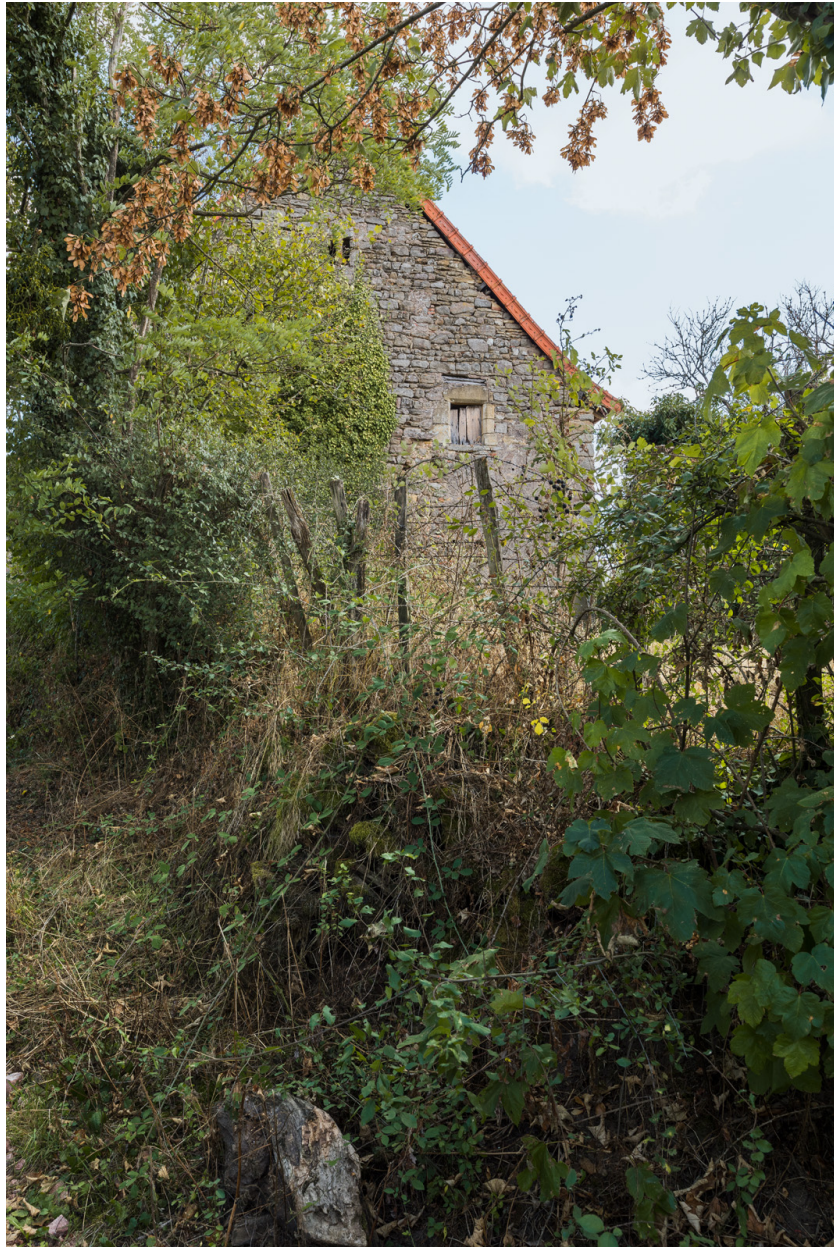
Pignon ouest de la partie agricole.
