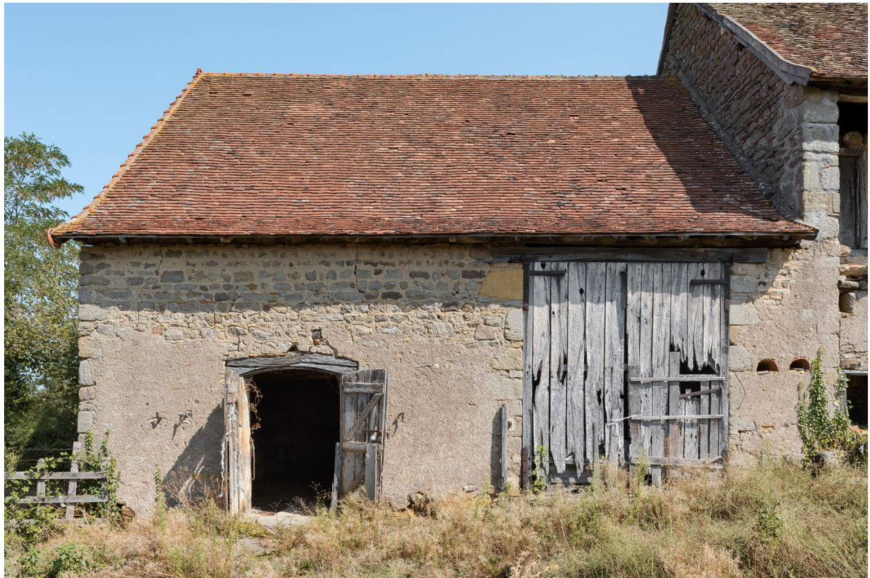
Vue de face des parties agricoles.
