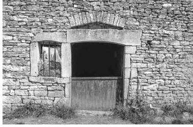
Détail : porte d'écurie sur façade latérale gauche. Phot. Bernard Lardière IVR43_19817000123Z
