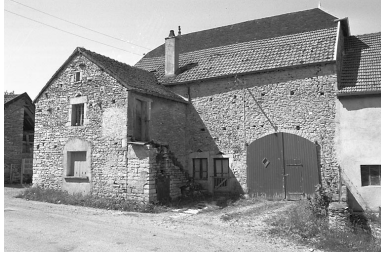
Vue d'ensemble. Phot. Bernard Lardière IVR43_19817000122Z
