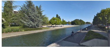
Vue d'amont. Phot. Thierry Kuntz IVR26_20112102735NUC4A
