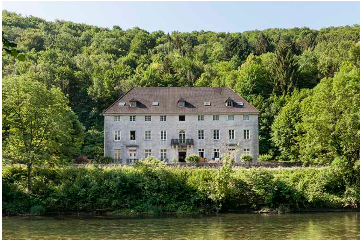
Façade antérieure du logement patronal.
