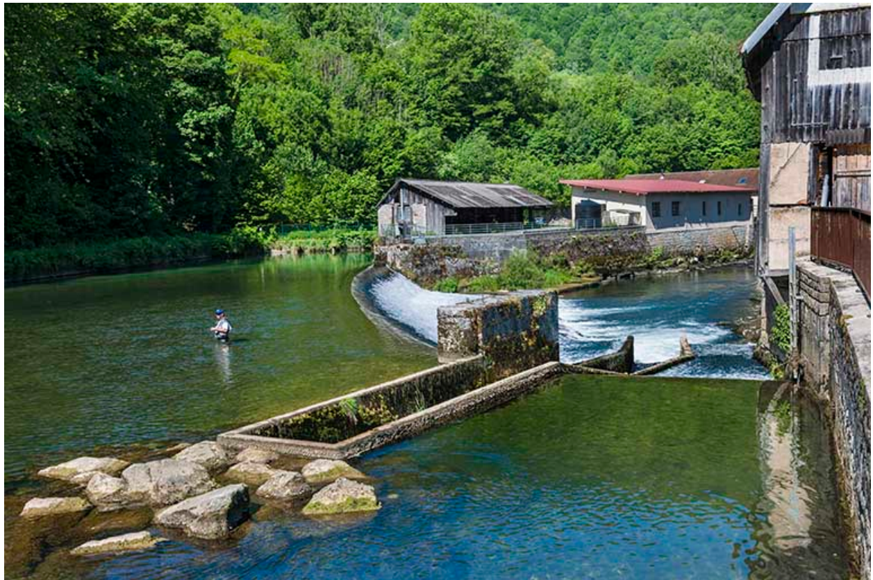
Le barrage de l'usine du Moulin-Neuf.
