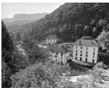
Vue plongeante des logements de l'usine du Haut en 1980. Phot. Yves Sancey IVR43_19802501006X
