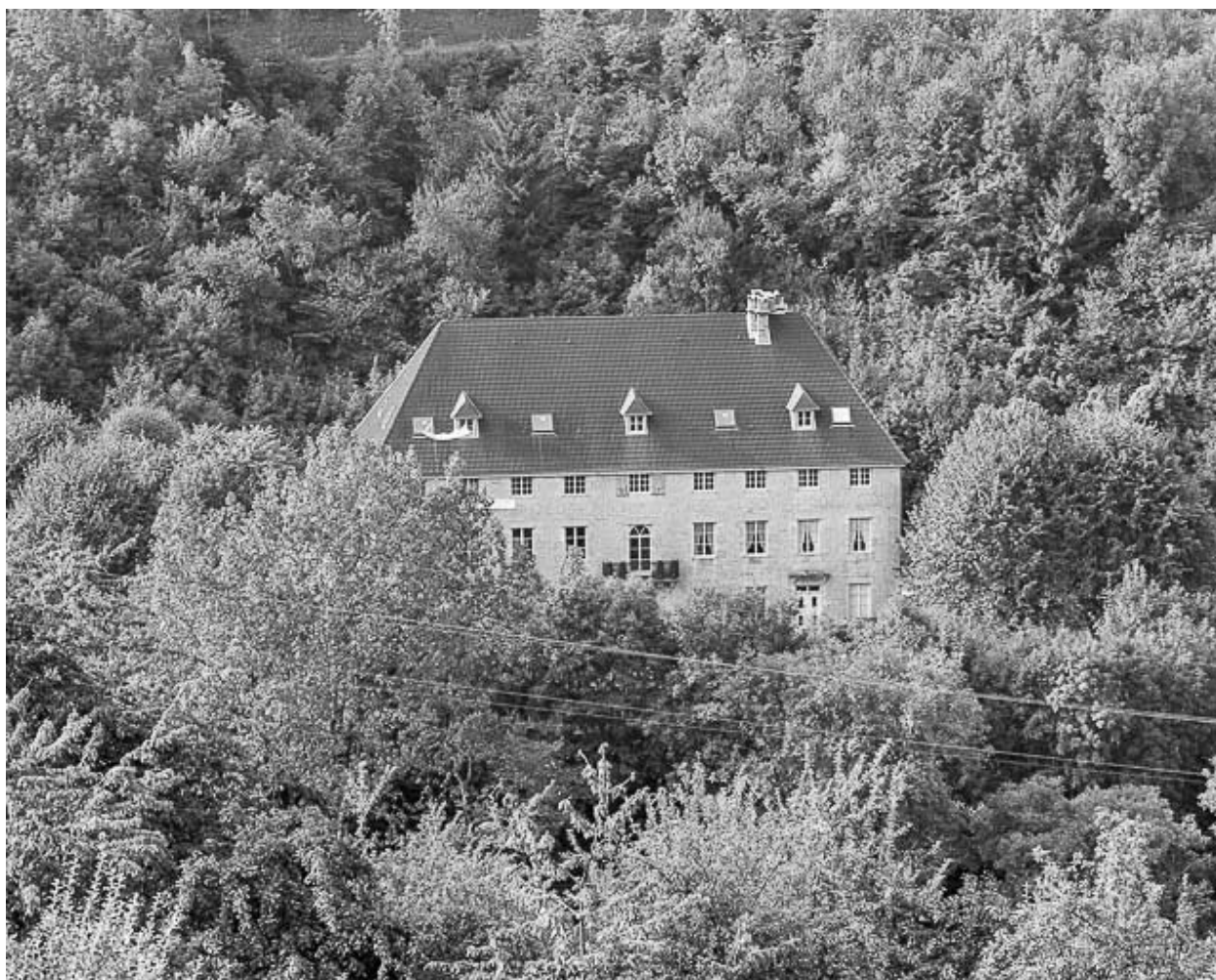
Vue plongeante sur le logement patronal en 1980.
