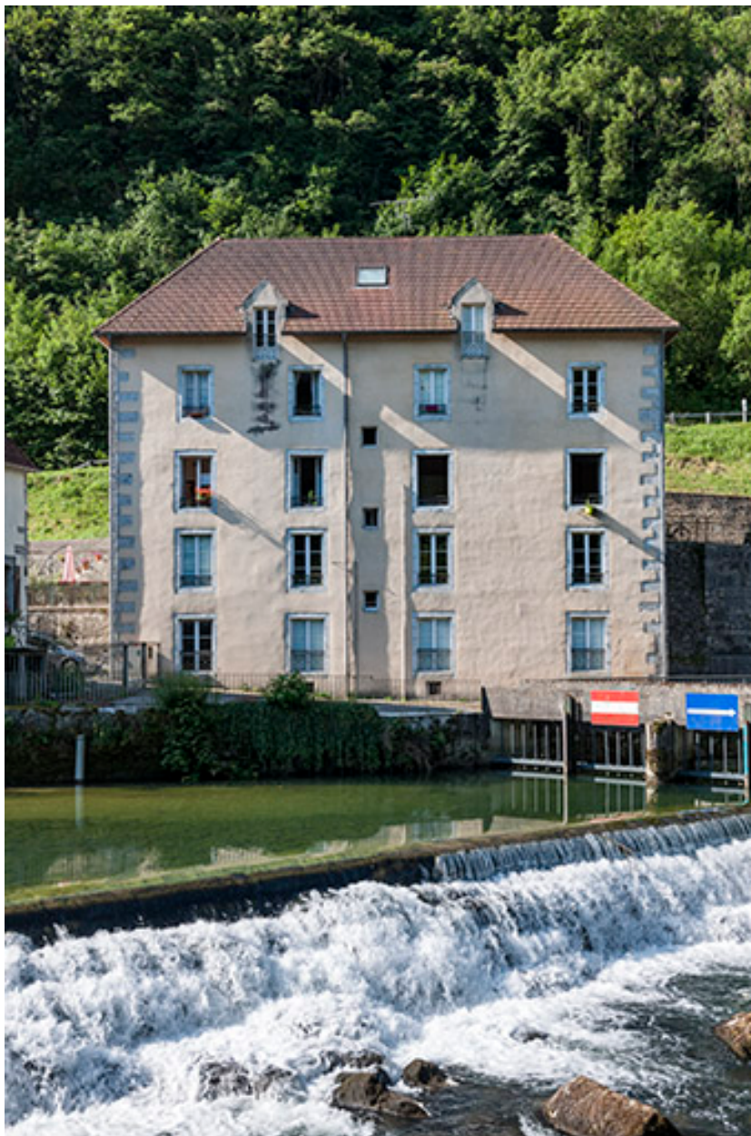
Façade nord d'un logement d'ouvriers.
