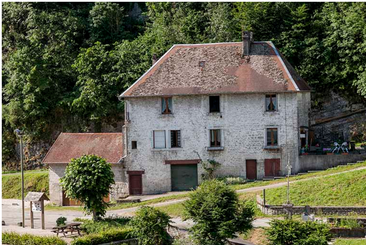
Logements d'ouvriers (route de Longeville).
