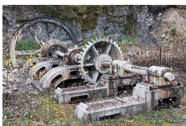
Turbine double. Vue de côté. Phot. Jérôme Mongreville IVR43_20152502490NUC4A
