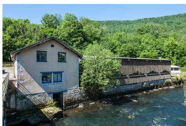
Usine du Moulin-Neuf. Bâtiments subsistants (logement ?). Phot. Jérôme Mongreville IVR43_20152501272NUC4A
