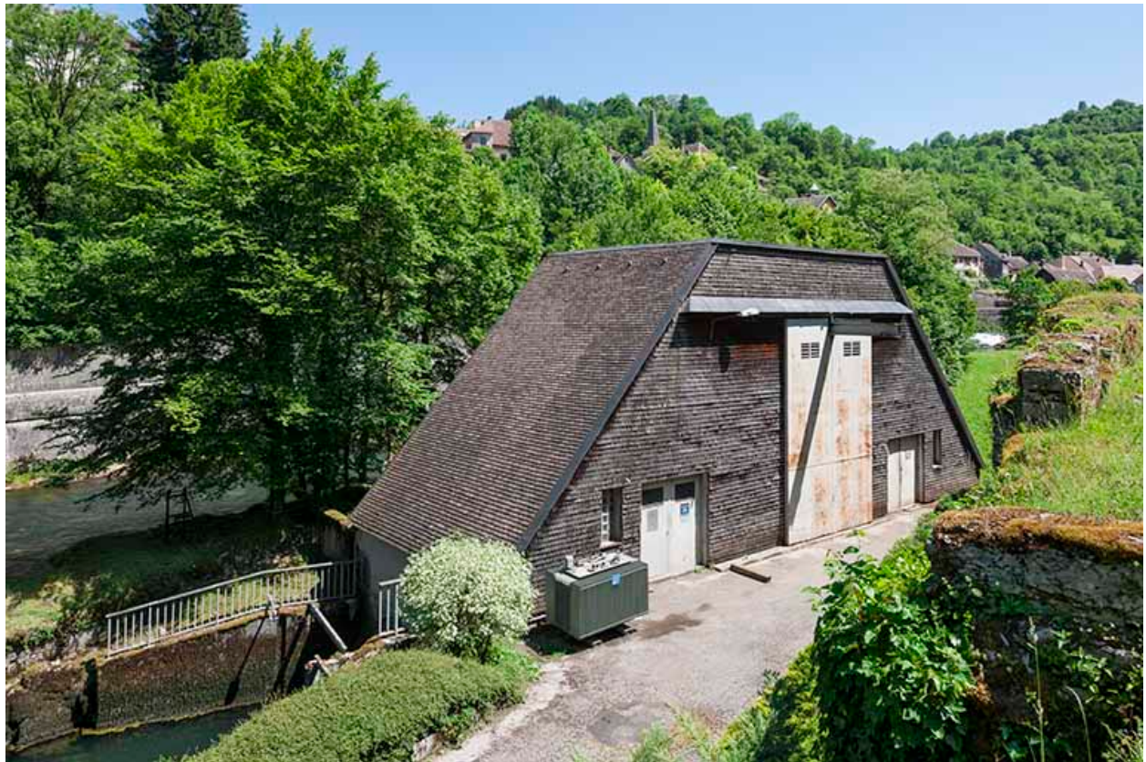
La centrale hydroélectrique vue de trois quarts.
