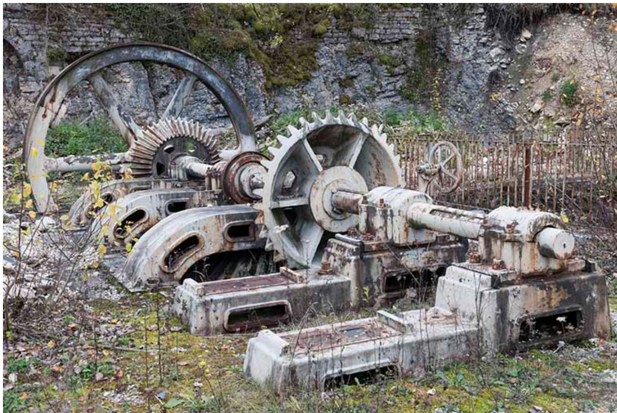
Turbine double. Vue de côté.
