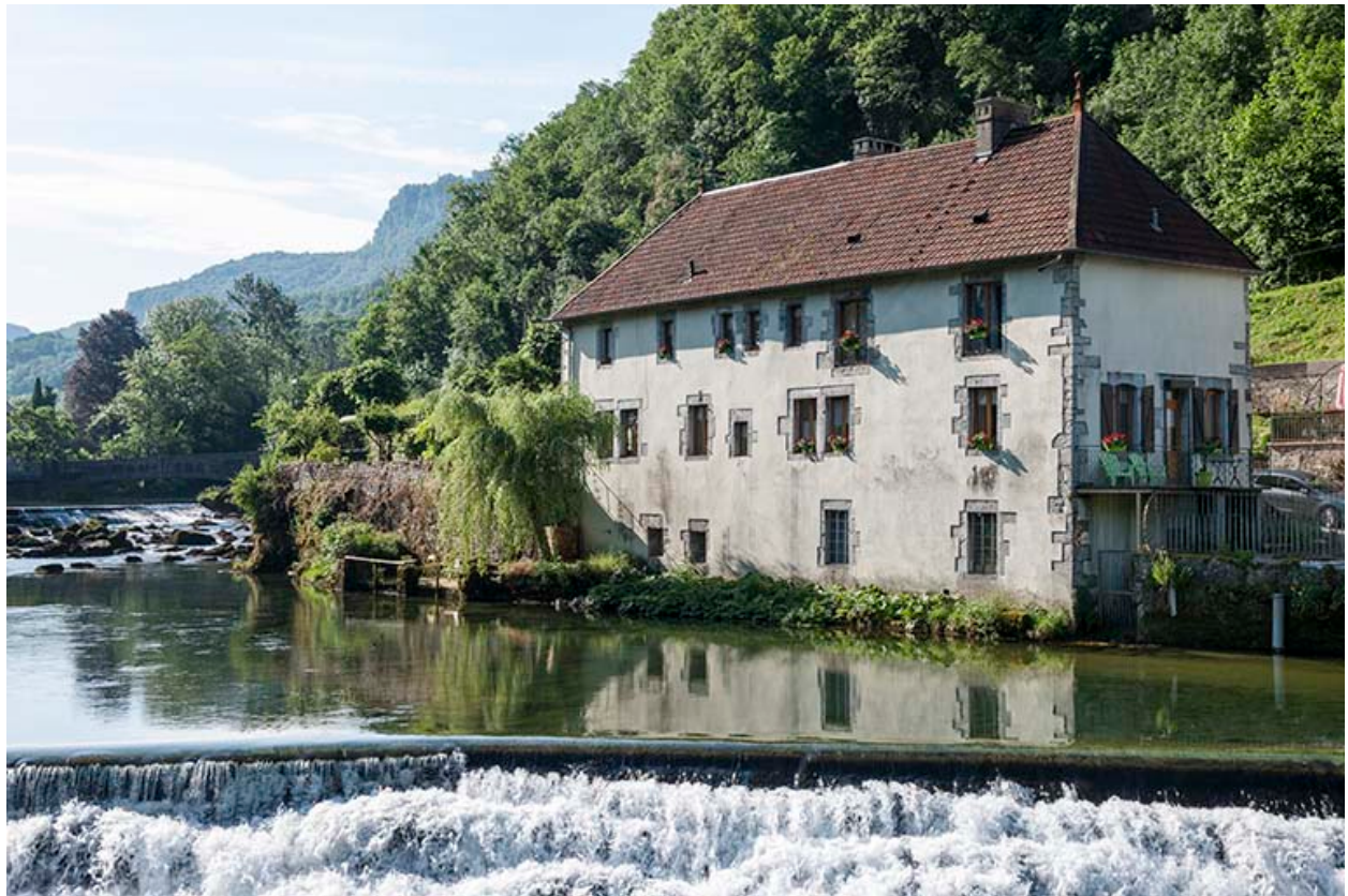
Logement d'ouvriers vu de trois quarts droite.
