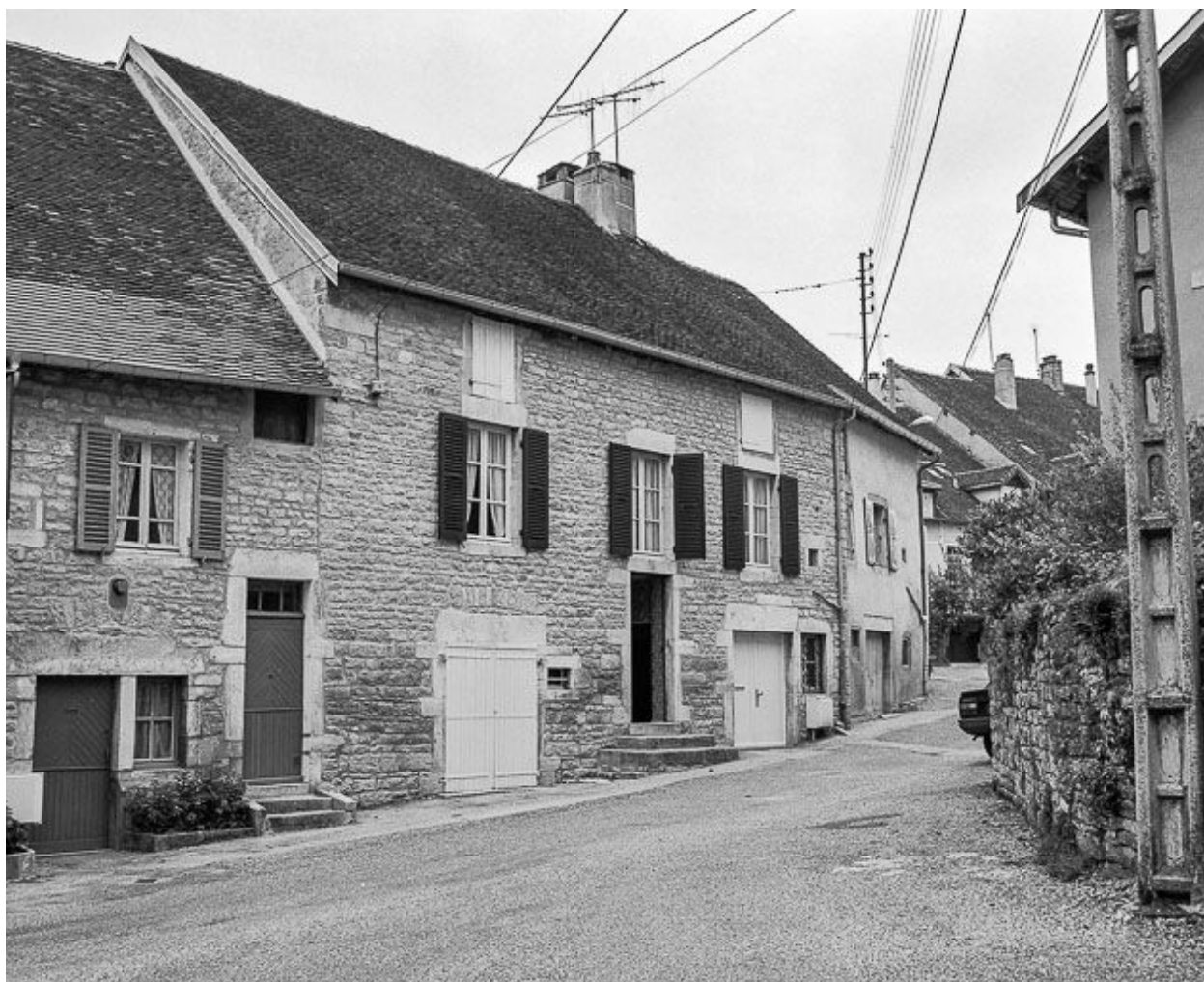
Maison de vigneron située rue des Micholettes.
