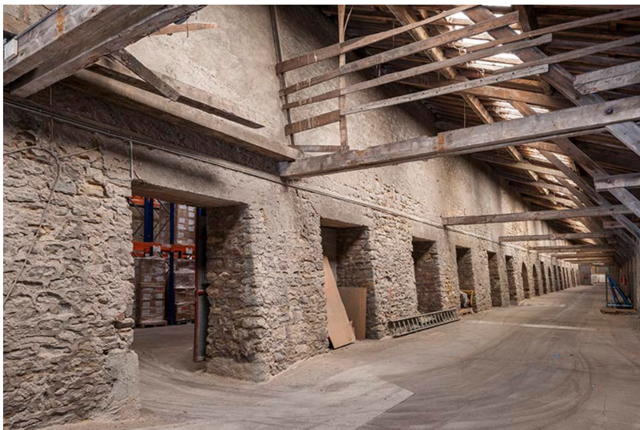
Atelier de fabrication (berne) : ancien quai.
