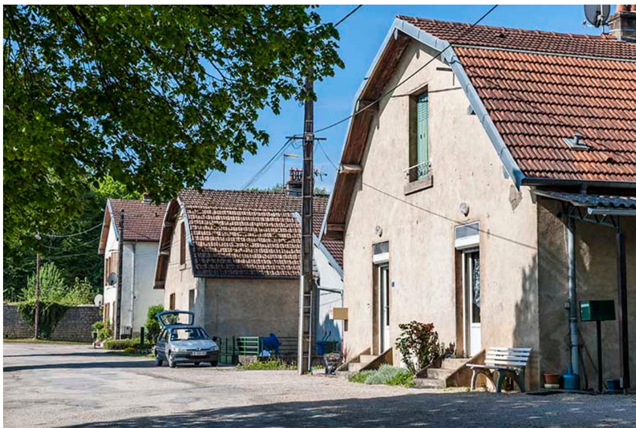
Pignons des logements ouvriers (allée des Rompeux).
