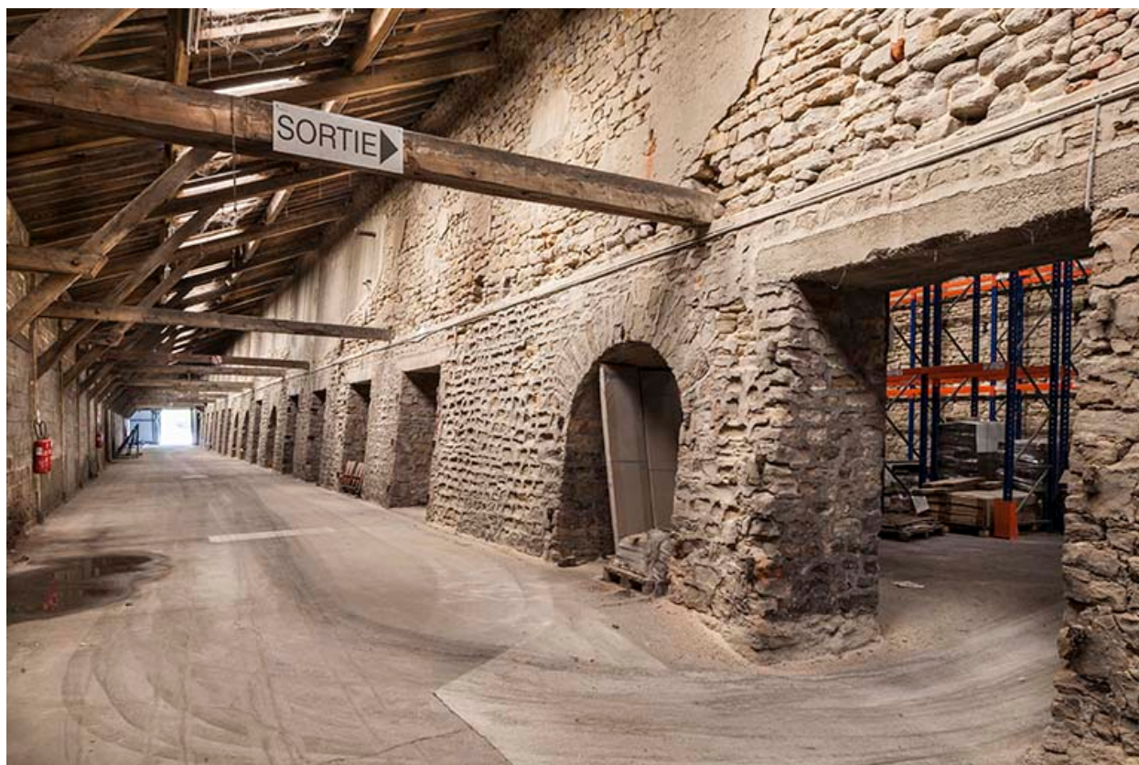
Ancien quai de chargement.
