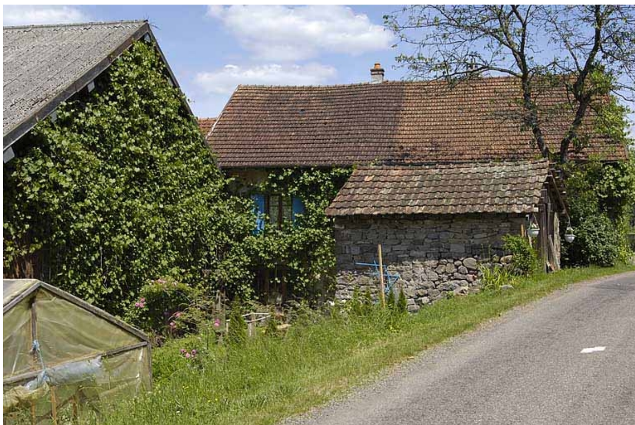
Façade postérieure du logement.
