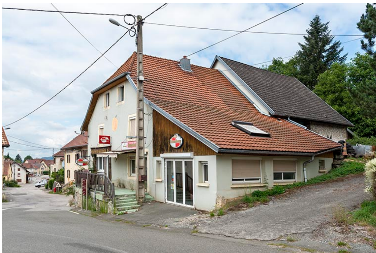
Façades antérieure et latérale droite.
