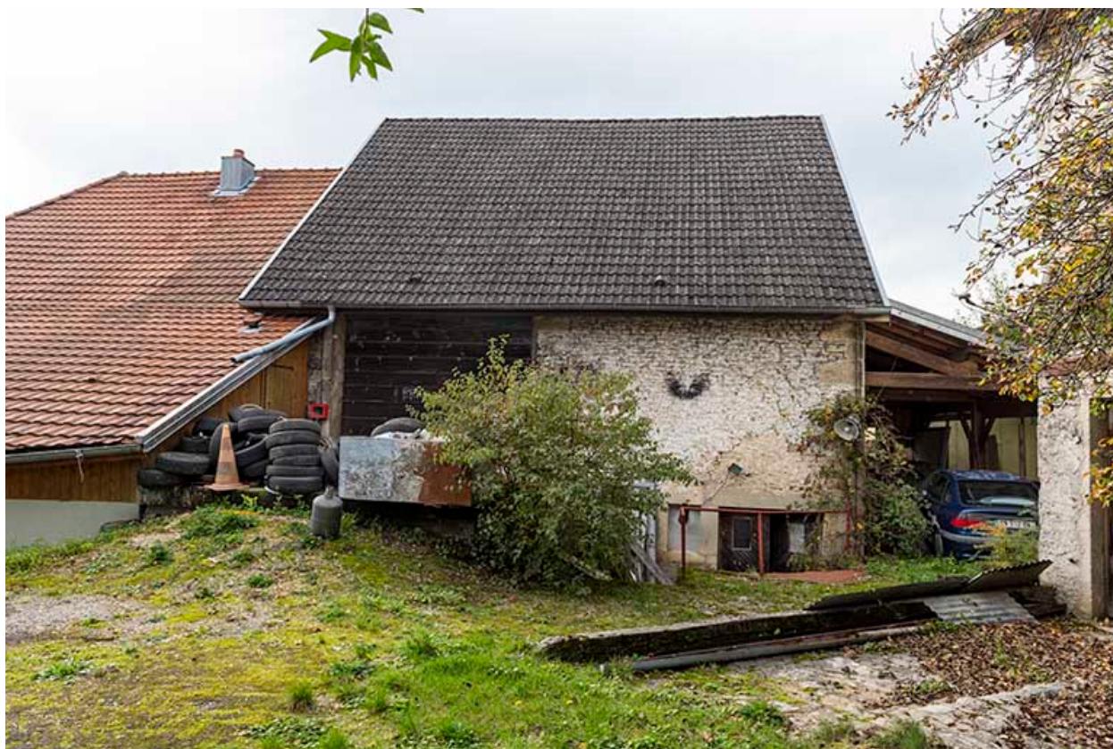
Façade latérale droite : la grange.
