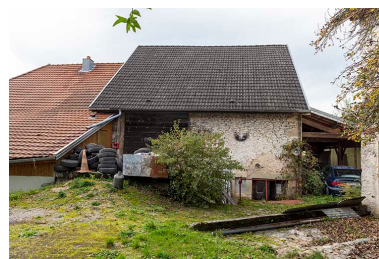
Façade latérale droite : la grange. Phot. Sonia Dourlot IVR43_20192501320NUC4A
